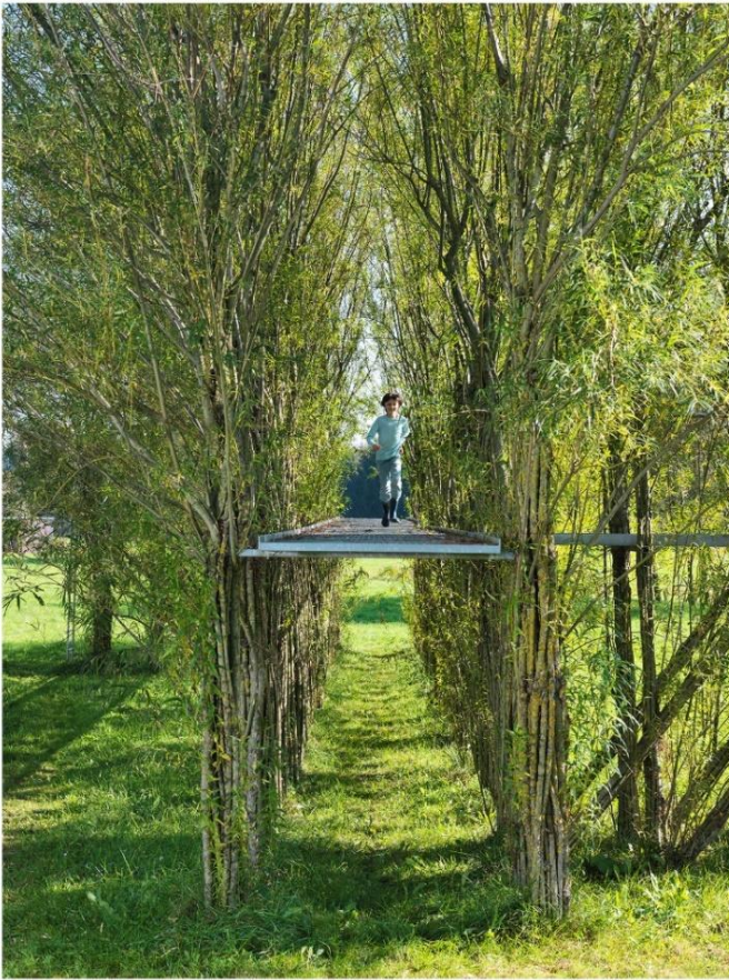
Fig. 07. Plataforma sostenida por árboles trenzados del arquitecto Ferdinand Ludwig. Fuente: https://www.archdaily.cl/cl/979485/baubotanik-el-sistema-de-diseno-de-inspiracion-botanica-que-crea-edificios-vivos
