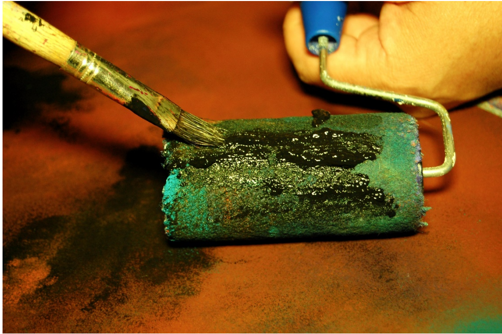
(Figura 10) Carga de pintura en rodillo para aplicación
