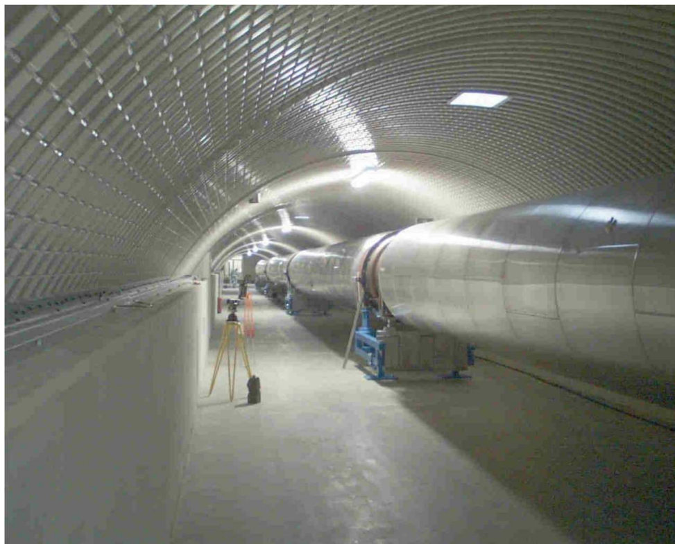
FIGURA 4. Interior del detector VIRGO de 3km de lado, cerca de Pisa, Italia.
