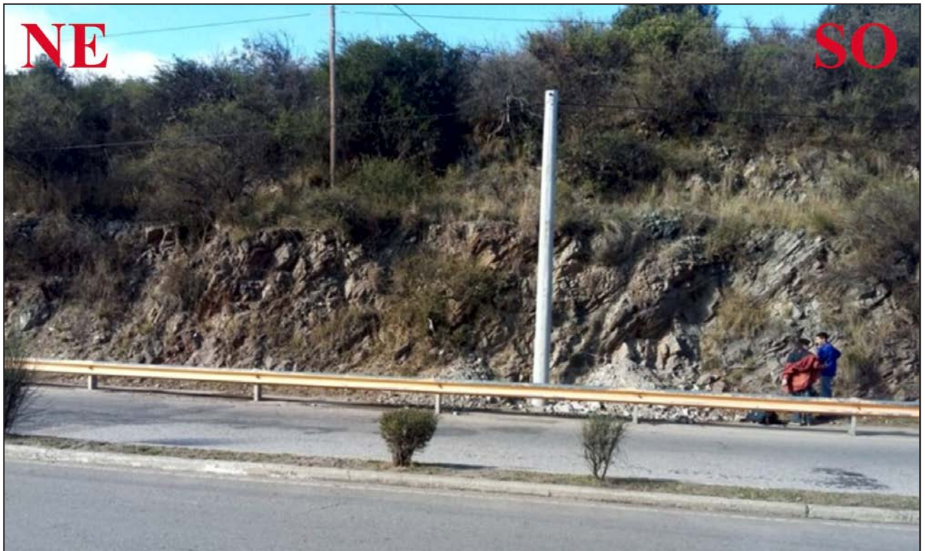
Figura 8. Vista panorámica al sudeste de un sector del talud N° 4.
