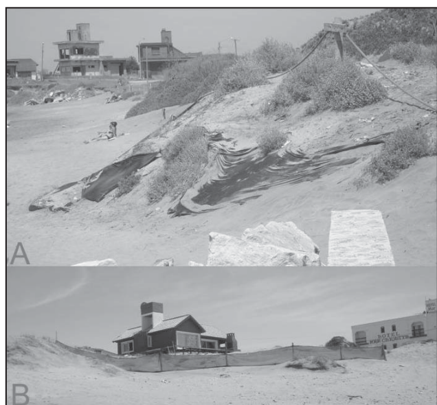
Figura 5. Barreras eólicas 1 y 2 (5A y 5B, respectivamente): la primera en estado de abandono, la segunda en funcionamiento. Tomada durante el relevamiento de enero de 2009.
