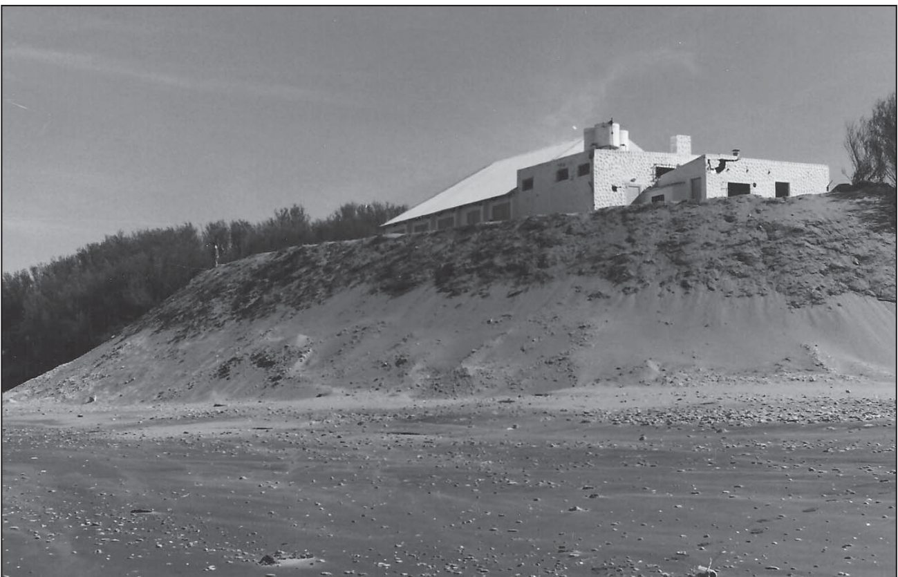
Figura 7. Obra cubierta con arena con sembrado de Carpobrotus edulis , "uña de gato".
