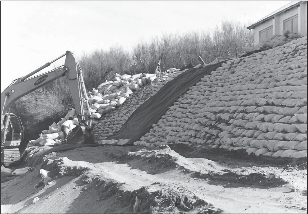
Figura 6. Colocación de membrana geotextil.
