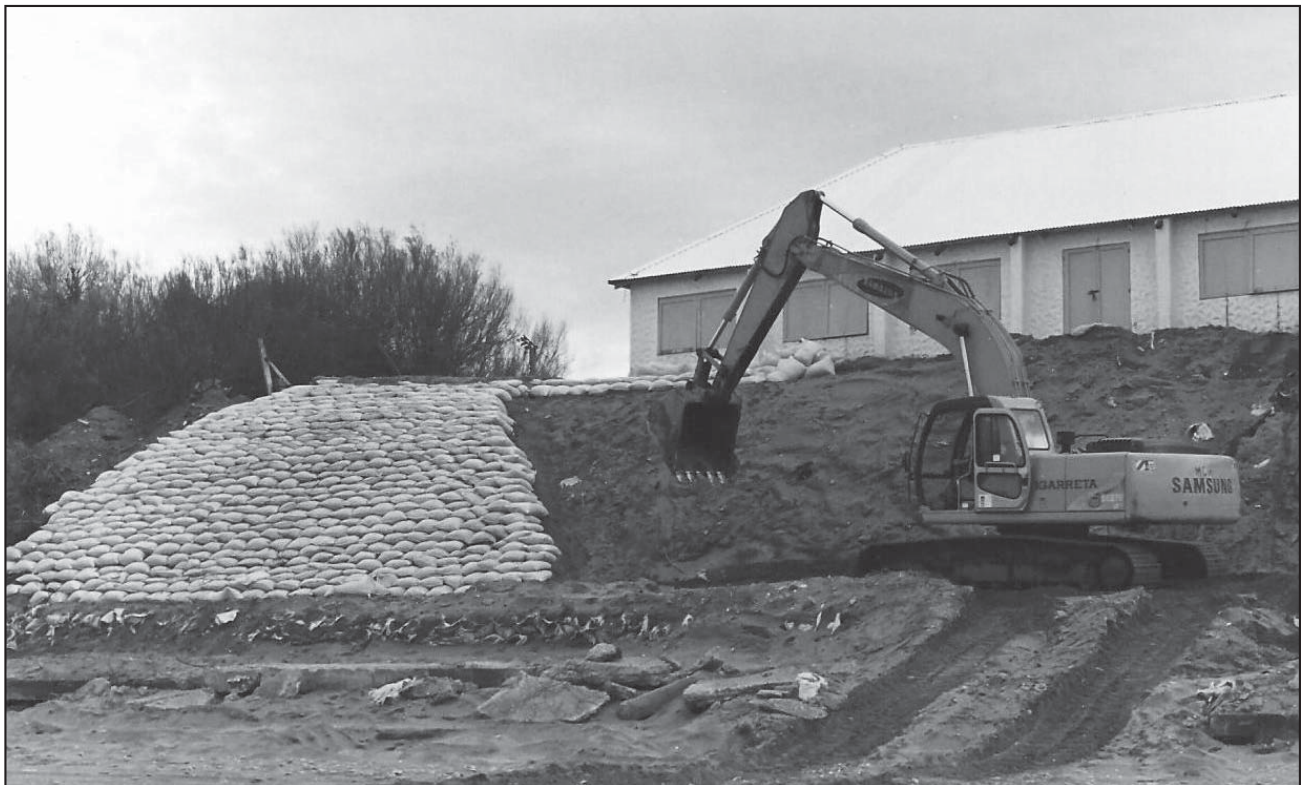
Figura 5. Colocación de las bolsas rellenas con arena.
