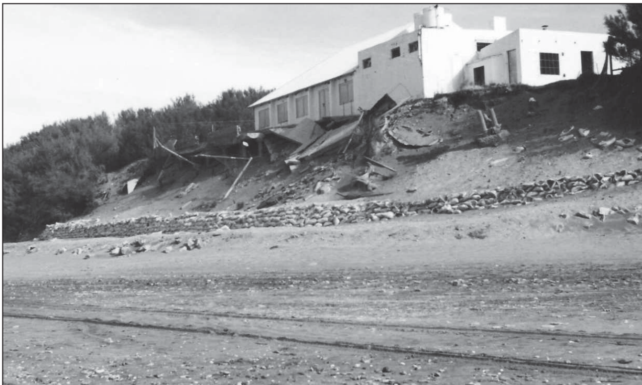
Figura 1. Estado de la duna y construcci6n al comienzo de las obras de defensa.
