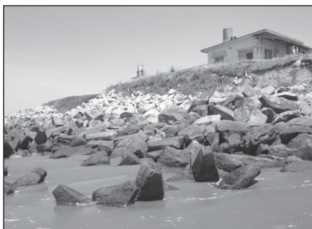
Figura 4. Acorazamiento 3, compuesto por rocas y hexápodos de hormigón. Tomada durante el relevamiento de enero de 2009.
