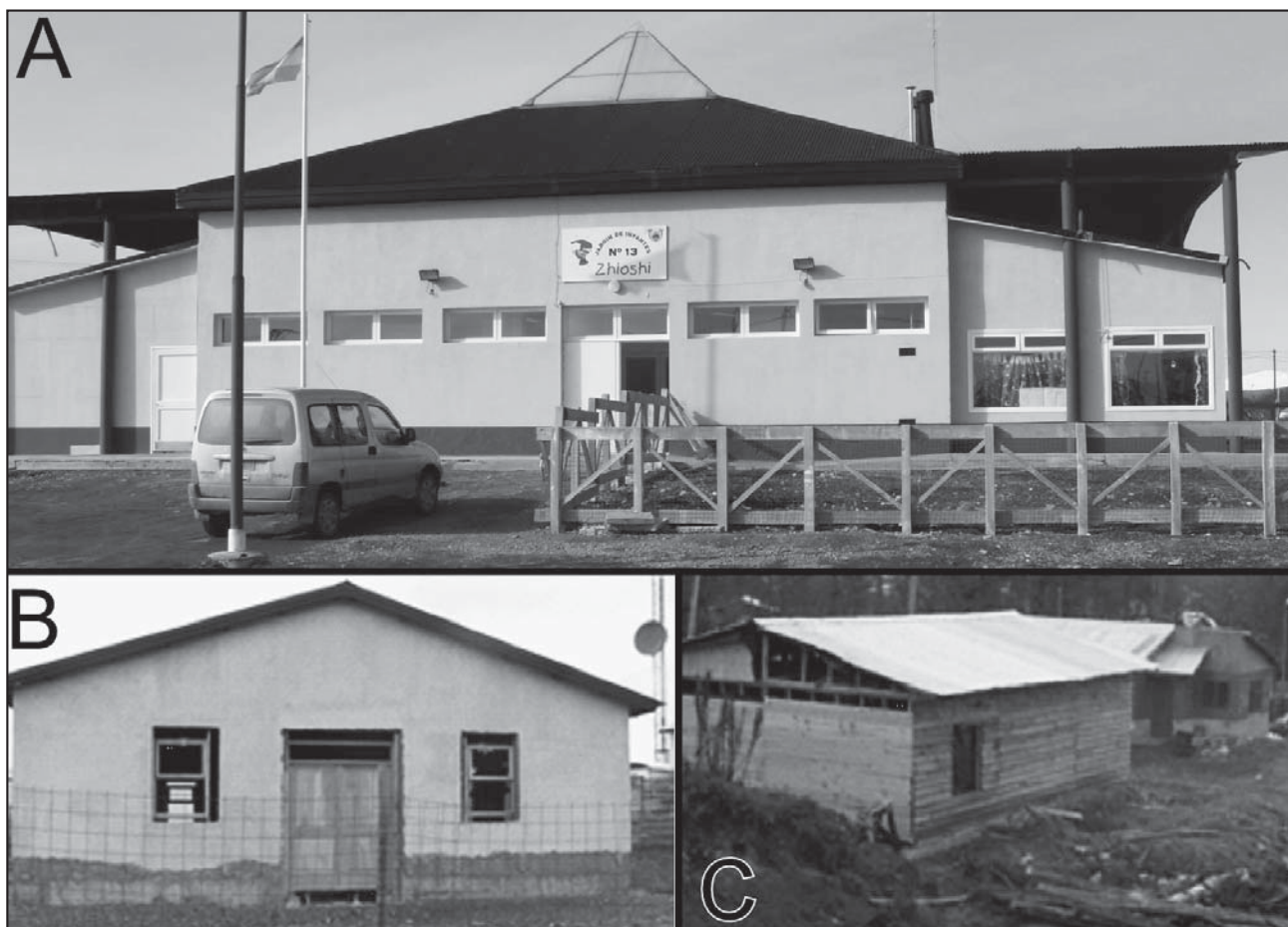
Figura 7. Ejemplos de los principales tipos edilicios en Tolhuin. A - Escuela (C1L). B - Vivienda de mampostería (C3L). C - Vivienda de madera (W1).
