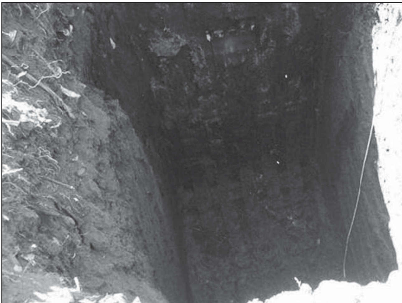
Figura 13. Calicata 8 (Progresiva 85,90 m). Presencia de 2,55 m de espesor de materiales arcillosos plásticos de color oscuro que suprayacen a las rocas del Basamento Cristalino Precámbrico.
