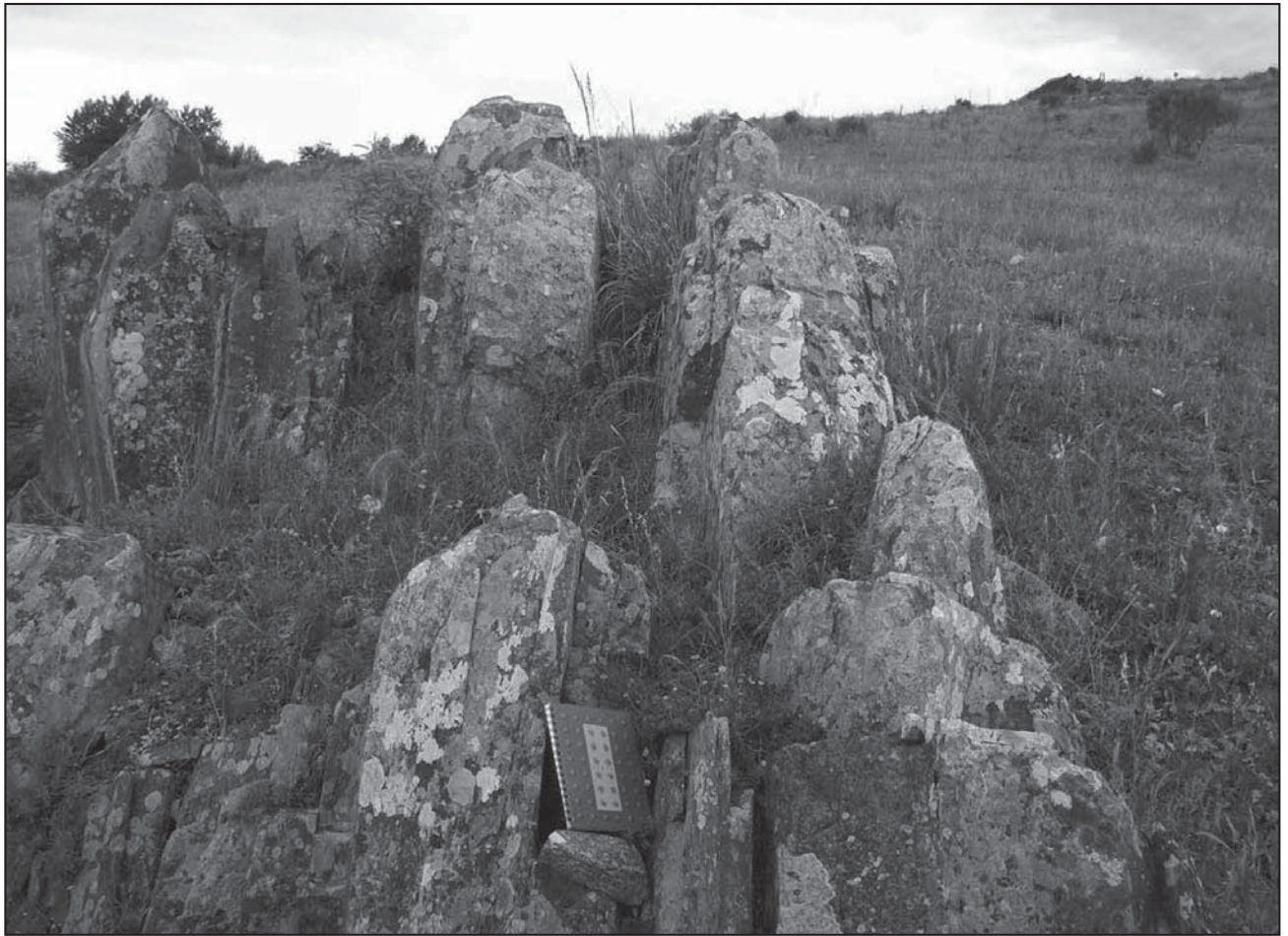
Figura 17. A° Blanco - Cierre 3 - Estribo margen derecha -Modelo de alteración 2: Detalle de la incidencia de la alteración entre discontinuidades- erosión de manera diferenciada.
