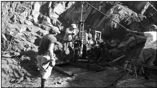
Figura 6. Progresiva 130 m. Sondeo complementario SC1. Perforación con extracción continua de testigos en el área del pie de presa sobre margen derecha (Actual Bloque 7).
