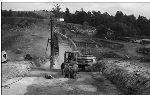
Figura 11. Sobre la superficie del hormigón de regularización se observa el equipo de perforación de los taladros de inyección sobre el lateral derecho de la fundación de la presa y personal colocando el sistema de obturación para la inyección de un tramo en un taladro de consolidación.
