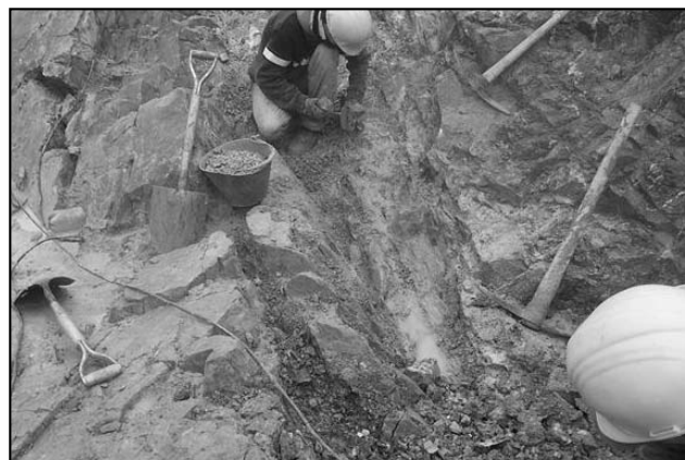
Figura 10. Saneamiento del contacto entre las rocas pegmatíticas y las rocas gneissicas.
