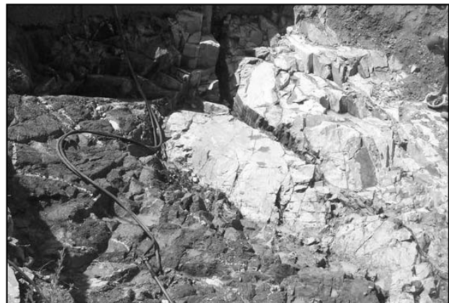
Figura 8. Vista del sector anterior (Figura 7) una vez finalizada la tarea de limpieza y previo al hormigonado de protección.
