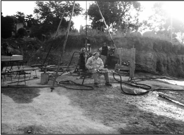
Figura 16. Control del tratamiento de inyecciones. Ejecución de ensayos Lugeon en el Bloque 4 - Perforación C.
