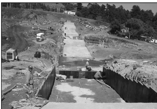
Figura 18. Zócalo de apoyo de la presa o plinto. Vista general desde el estribo de margen derecha de la totalidad del zócalo de apoyo. En primer plano se observa la colocación de los módulos para la construcción del bloque 10 de la presa.
