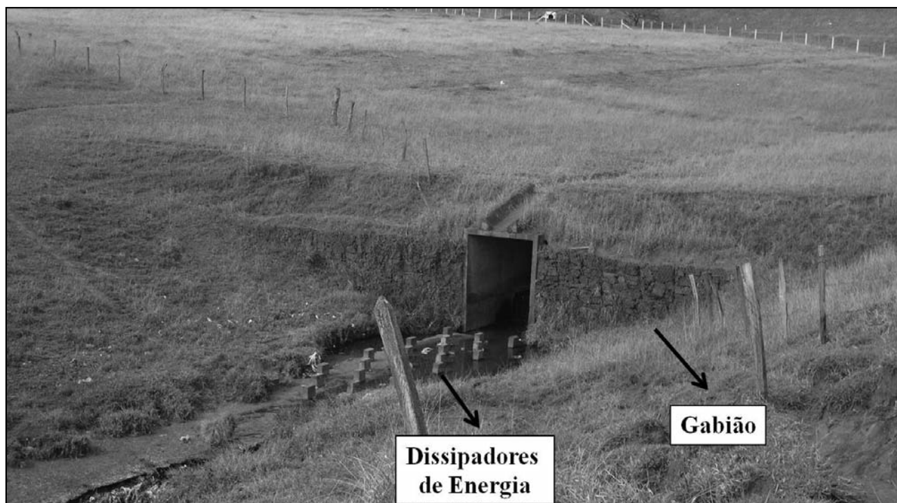
Figura 19. Fim da canalização do canal de drenagem da Área 6, com a presença de dissipadores de energia na saída da canalização.
