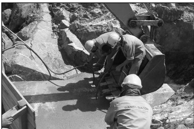
Figura 15. Saneamiento dental. Vibrado del hormigón H13 de reemplazo de la roca extraída de baja calidad geomecánica en el sector saneado.
