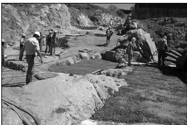
Figura 17. Vista general del saneamiento efectuado en el lateral izquierdo de la presa previo a la construcción del zócalo de apoyo u hormigón de regularización o plinto.
