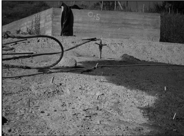
Figura 14. Bloque 1. Al fondo, obturador instalado en un taladro de inyección. En primer plano se observan los taladros de inyección de consolidación finalizados y demarcados para su individualización y control del desarrollo de la operación del tratamiento.
