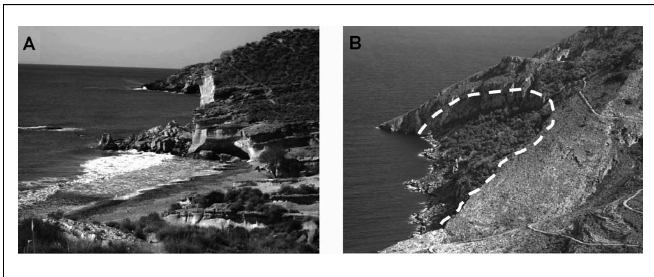
Figura 14. Distintos movimientos de ladera observados en el litoral de la Región de Murcia (España): A) desprendimiento, B) deslizamiento.
