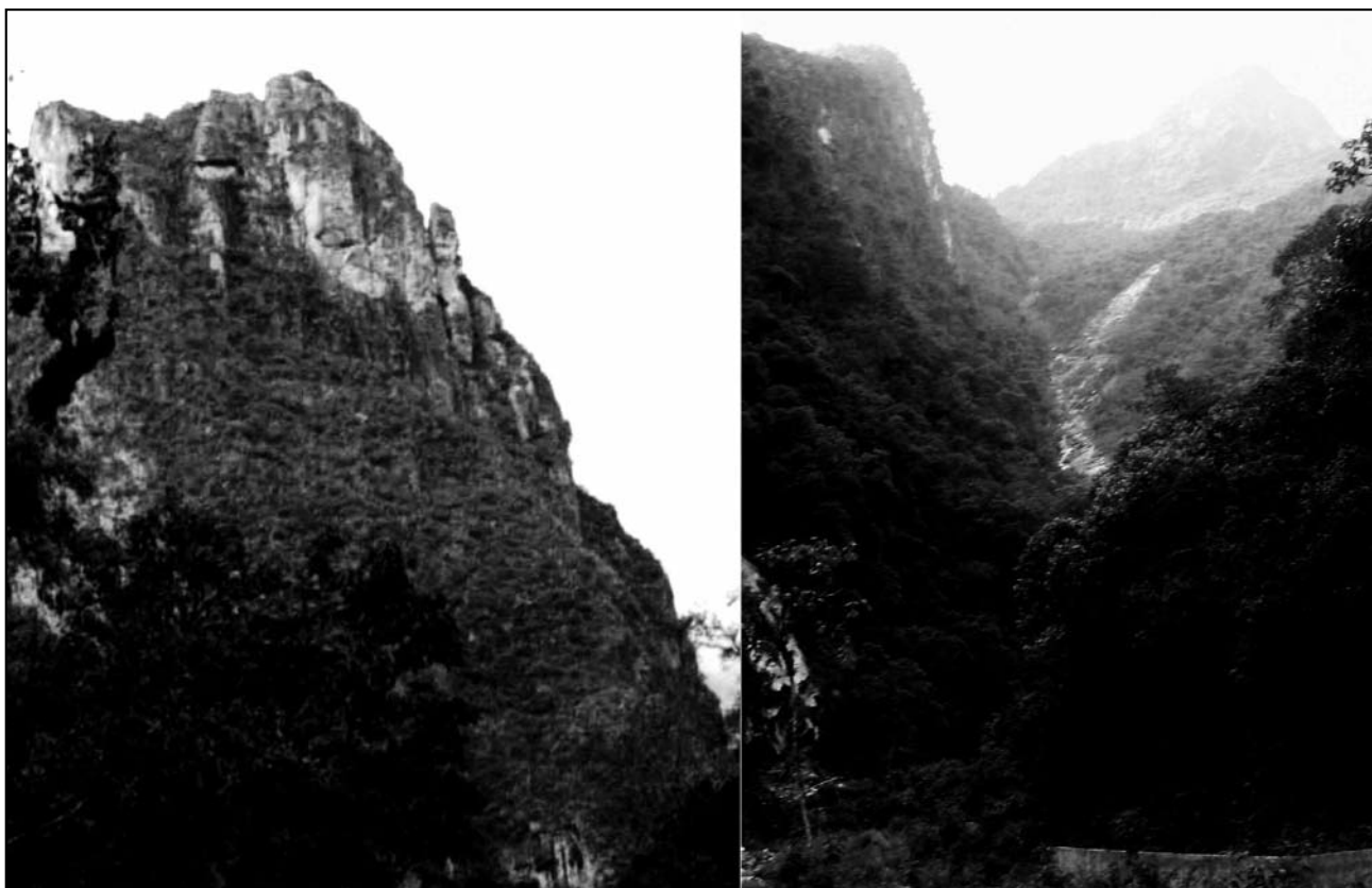
Figura 12. Ejemplo del muy abrupto e inestable relieve del cañón de Torontoy: a la izquierda, farallón afectado por procesos de toppling; derecha: uno de los frentes de origen de los huaycos de Aguas Calientes de 1998 y 2007.
