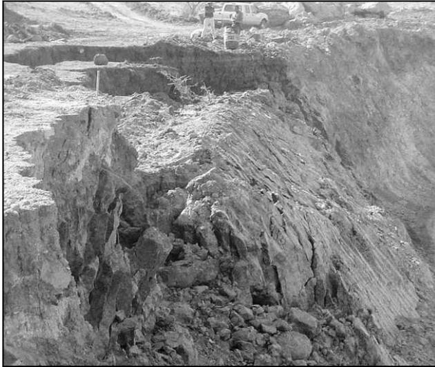
Figura 1. Rotura de talud en arcillas agrietadas, localizado en el par vial de Tres Marías, Morelia Michoacán, México.
