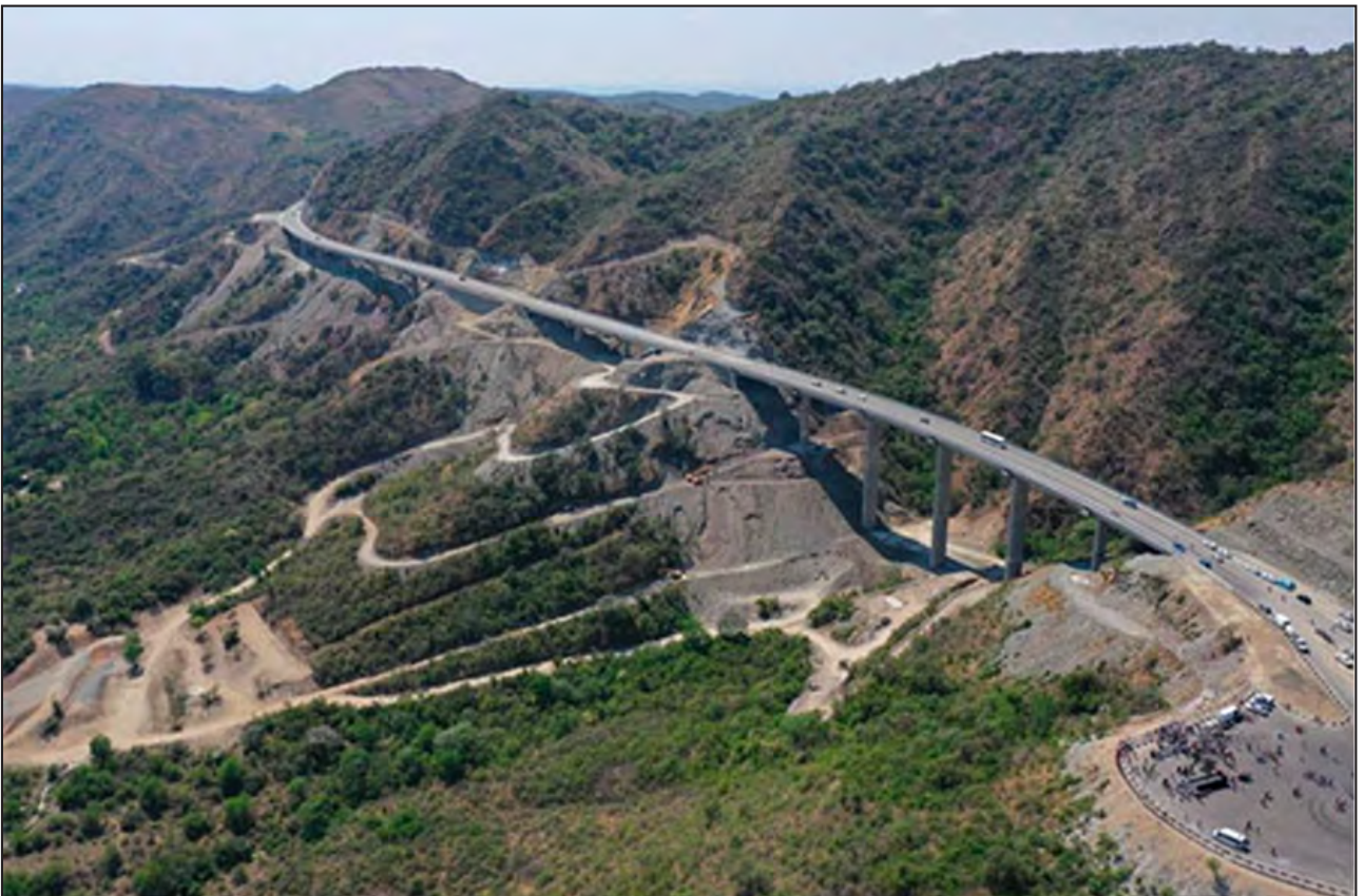
Figura 17. Vista general del sistema de viaductos.
