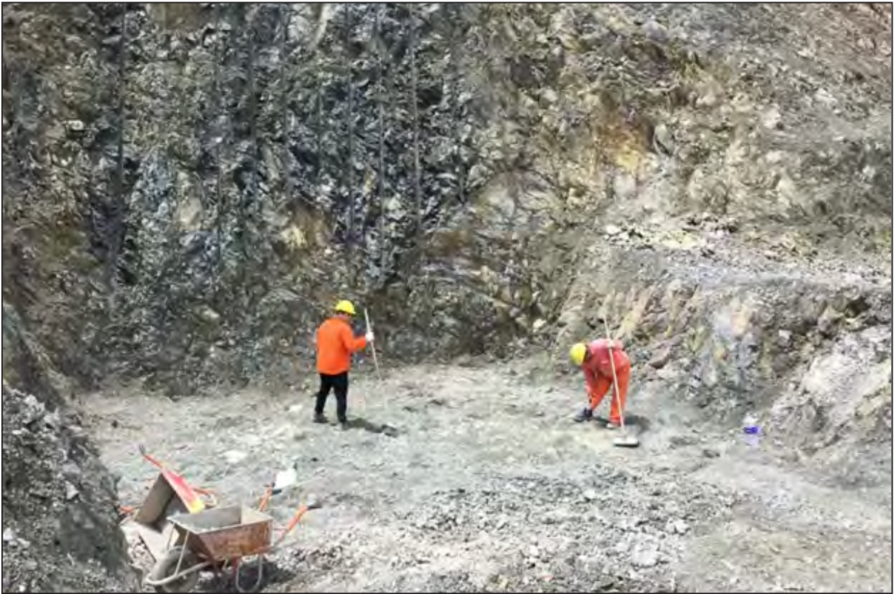
Figura 14. Vista de trabajos de limpieza del plano de apoyo.
