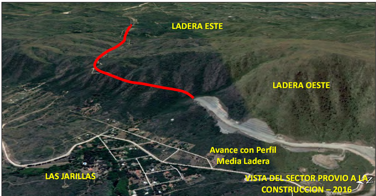
Figura 7. Vista del sector de viaductos previa a su ejecución, y del sector de trazado ejecutado por excavación y terraplenado.
