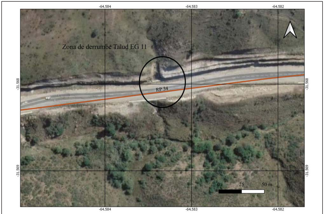
Figura 3. Zona de derrumbe en talud EG11.
