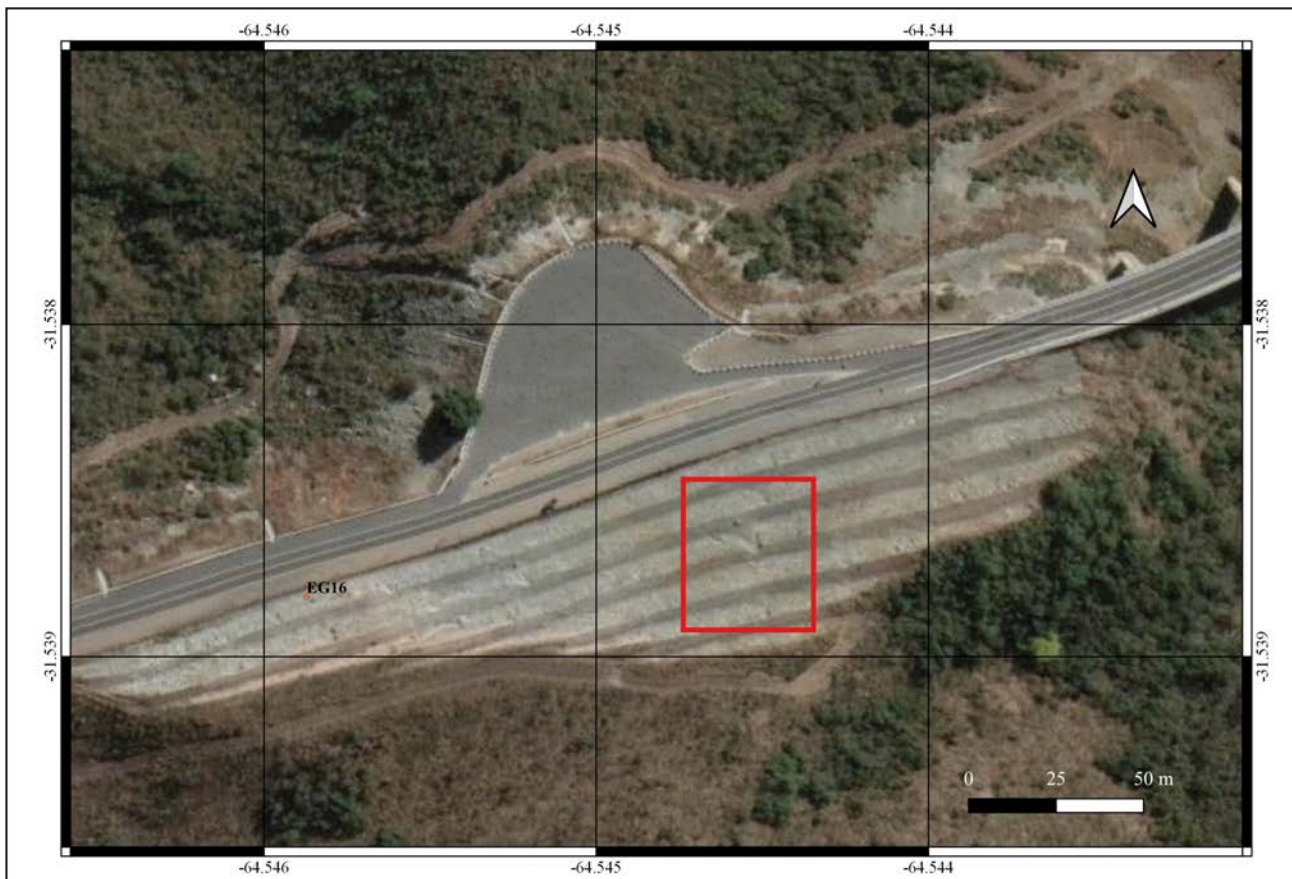
Figura 8. Ubicación del desprendimiento principal en talud EG16.
