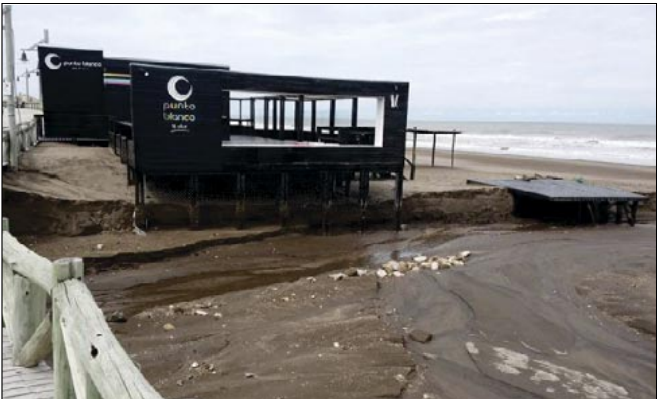
Figura 4 y 5. Destrozos en la costanera de Monte Hermoso debido a temporal de lluvia. Fuente: lanueva.com / Agencia Monte Hermoso. Marzo, 2017.
