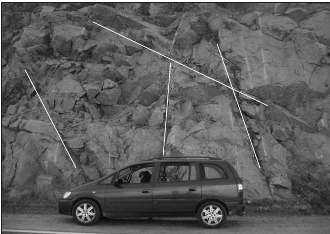
Figura 3. Desprendimientos y derrumbes de taludes altamente fracturados.
