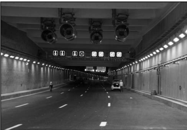
Figura 9. Túnel Benfica, CRIL.
