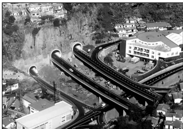
Figura 6. Túnel Vale Ribeira de Santa Luzia.
