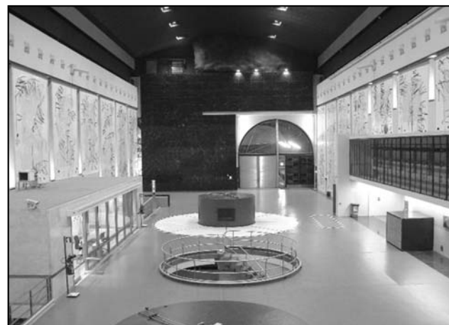
Figuras 16. Central de Frades.
