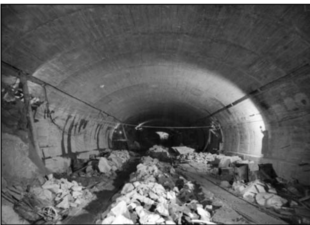
Figuras 8. Túnel Ribeira do Porto.
