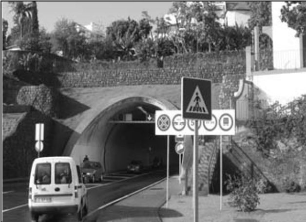
Figura 7. Túnel Nuevo Acceso al Puerto de Funchal.
