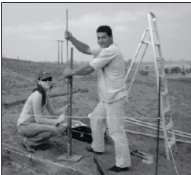
Figura 3. Visão geral do ensaio com penetrômetro dinâmico.
