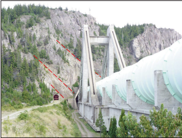
Figura 13. Talud excavado, correspondiente a la Boca II del túnel de aducción. En líneas roja, se indican tres zonas de falla.
