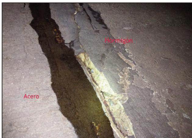
Figura 16. Contacto entre el revestimiento de hormigón del túnel de aducción, y el comienzo de la tubería de acero, en transición al puente tubería.
