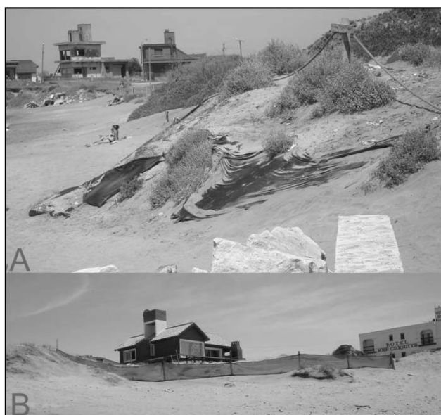
Figura 5. Barreras eólicas 1 y 2 (5A y 5B, respectivamente): la primera en estado de abandono, la segunda en funcionamiento. Tomada durante el relevamiento de enero de 2009.
