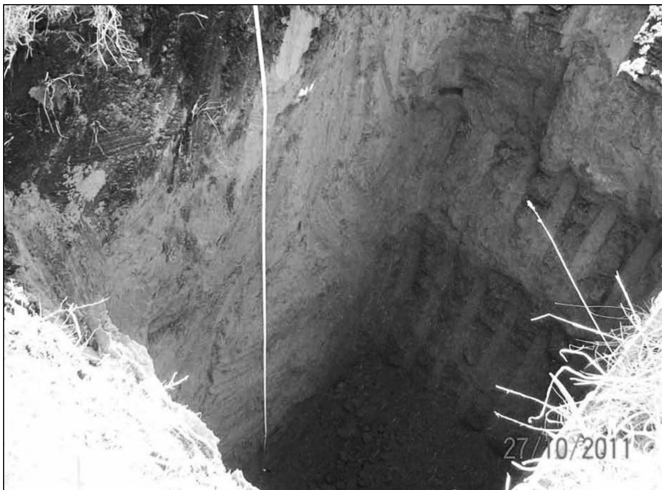
Figura 10. Calicata 2 (Progresiva 235,24 m). Suelo vegetal hasta 0,75 metros y limo arenoso fino de origen eólico que lo subyace hasta el final de la excavación a 4,20 metros de profundidad.
