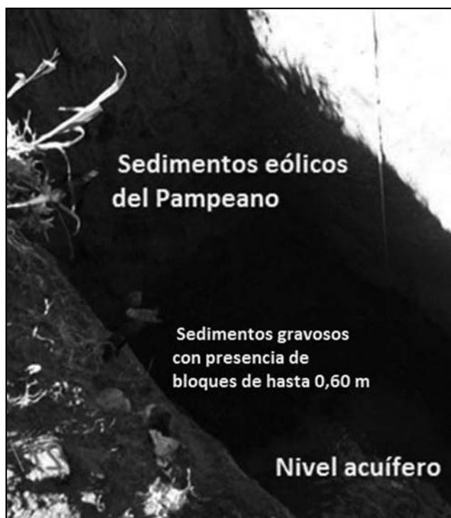
Figura 11. Calicata 4 (Progresiva 165,26 m). Sedimentos eólicos (3,30 m de espesor) suprayaciendo a sedimentos fluviales psefiticos. Se detectó la presencia de nivel acuífero.
