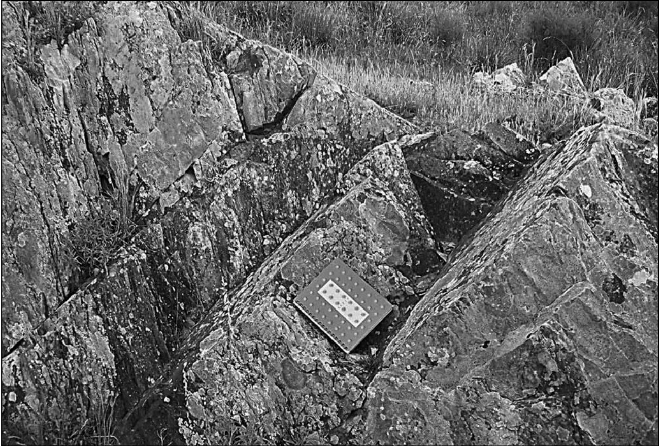
Figura 19. A° Blanco- Margen derecha- Área del estribo. Visualización del complejo cuadro de fisuración del macizo rocoso observándose buena calidad geomecánica de la matriz rocosa entre diaclasas.
