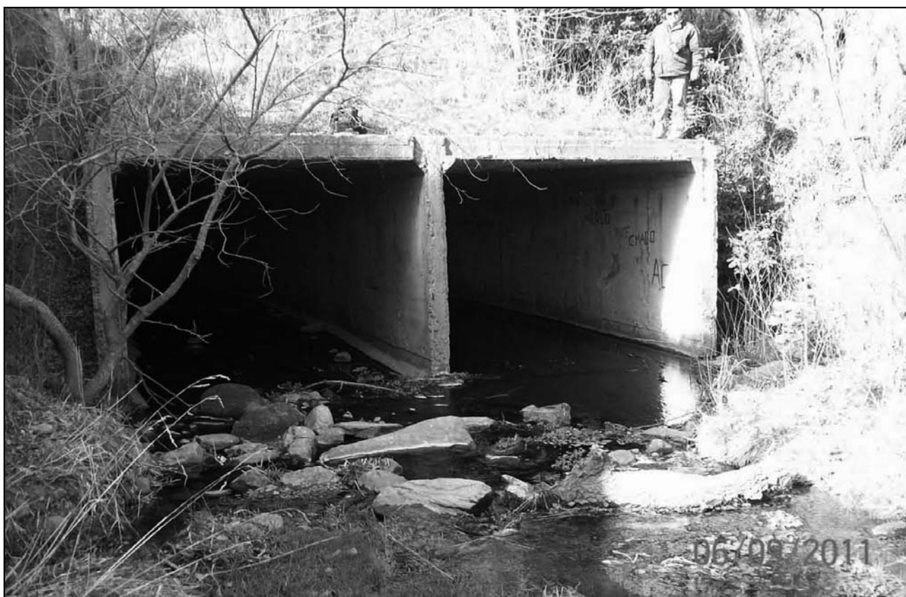
Figura 3. Vista del inicio del entubado del Arroyo Blanco, aguas arriba del eje de cierre de la futura presa.
