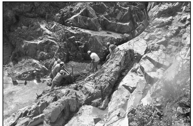
Figura 14. Proceso de hormigonado de reemplazo durante el saneamiento de zonas de alteración con presencia de cizalla en rocas de composición gneissica tonalítica cercanas al contacto gneiss - pegmatita.
