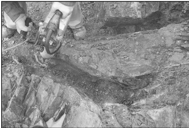
Fotografía 11. Detalle del calafateo de zonas fisuradas y alteradas en la roca de fundación.
