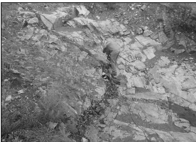
Figura 7. Sector demarcado para limpieza y calafateo de material muy fisurado con parcial presencia de arcillas plásticas rellenasdo fisuras entre progresivas 170 a 180.
