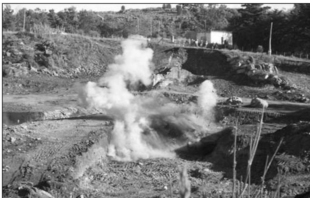
Figura 3. Excavación gruesa de la fundación - voladura de roca.
