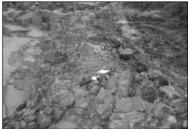
Figura 6. Área de estribo de margen derecha. Dique de rocas pegmatíticas rosadas en el plano de fundación previo a las tareas de saneamiento del contacto con rocas de composición gneissica. Se observa buena calidad geomecánica de la matriz rocosa pero con intensa presencia de fisuras, en parte rellenas de arcillas.
