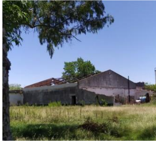
Figura 2: Edificio de faena abandonado. Entre Ríos Fuente: Autoría propia.
