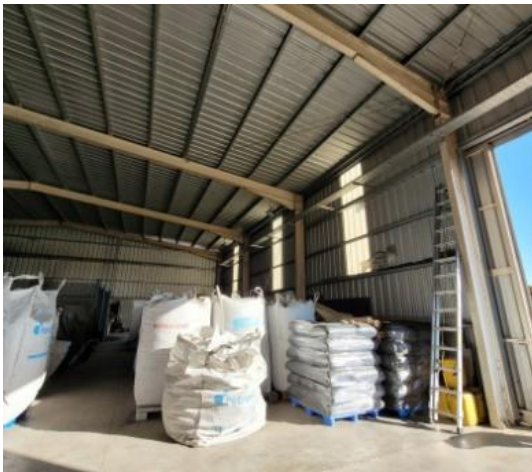
Planta Freyplast. Córdoba Fuente: Autoría propia.
