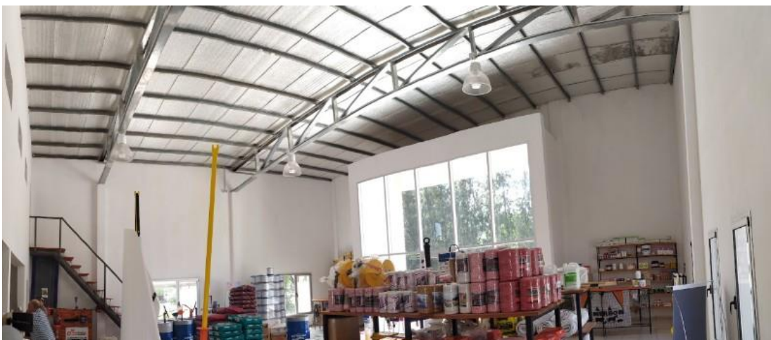
Figura 5: Edificio destinado a la producción y venta de alimento para animales. Entre Ríos Fuente: Autoría propia.
