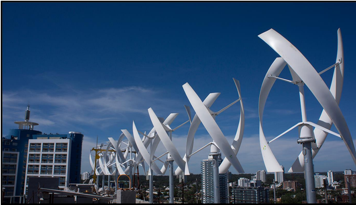
Nueve aerogeneradores de 1Kw de potencia colocados sobre el edificio Alexander En Punta del Este (Proyectó Estudio Cinco)
