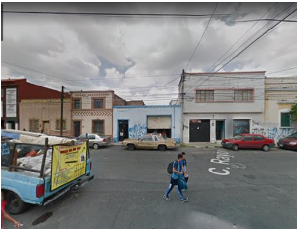
Figura 4. Espacio residual sobre la calle Epigmenio González, hasta el cierre con la calle Rayón. Fuente: Google maps
