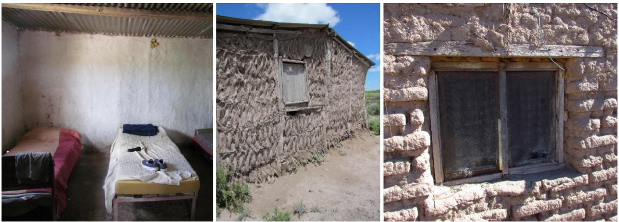
Figura 3. Técnicas para cerramientos verticales. Izq: Quincha; Centro 9 : enchorizado; Der: adobe. Fuente: Fotografías de la autora (2019 y 2021).
