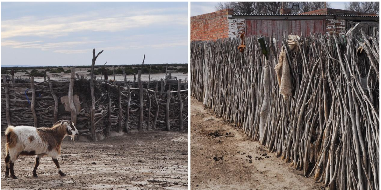
Figura 5. Técnicas de cerramientos verticales para espacios semiabiertos. De Izq. A der.: Técnica de cajón y técnica de jarilla parada. Fuente: Fotografías de la autora (2019).
