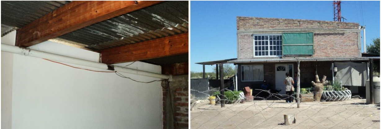
Figura 7. Materiales industrializados incorporados a las construcciones de estas últimas dos décadas. Fuente: Fotografías de la autora (2018).
