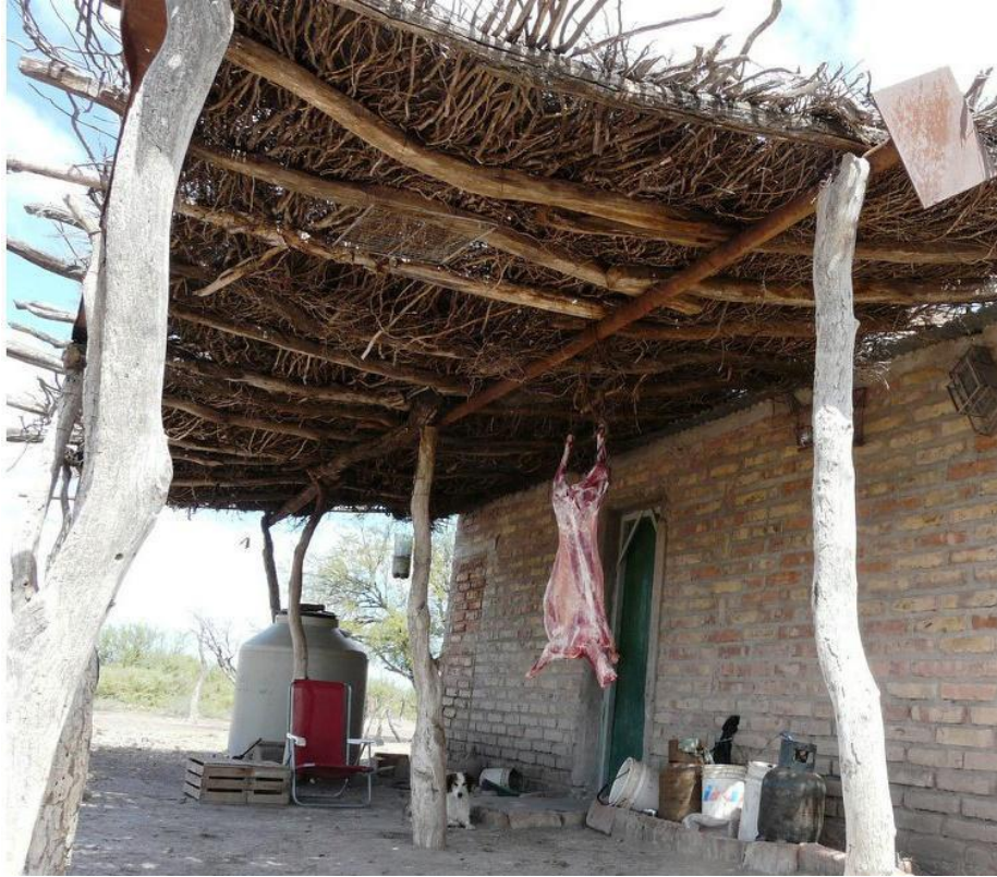
Figura 4. Técnicas de cubierta: Enramada sin torteado. Fuente: Fotografía de María Eugenia Comerci (2018).
