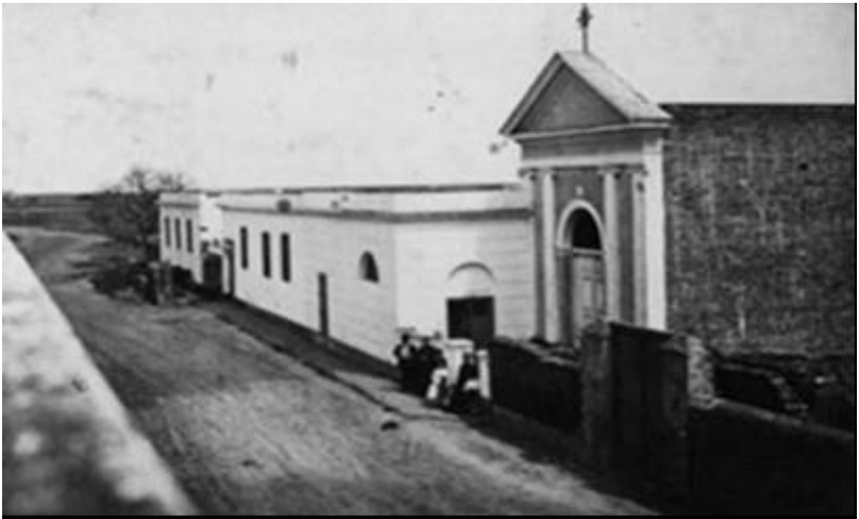
Figura 3. Hospital de Caridad. Alem y 9 de Julio. Fuente: FAPyD-UNR
