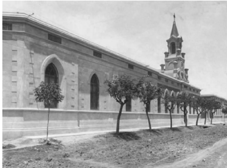
Figura 8. Asilo del Buen Pastor: Cárcel de mujeres 1896. Laprida, Virasoro, Buenos Aires y Gálvez. Fuente: FAPyD-UNR
