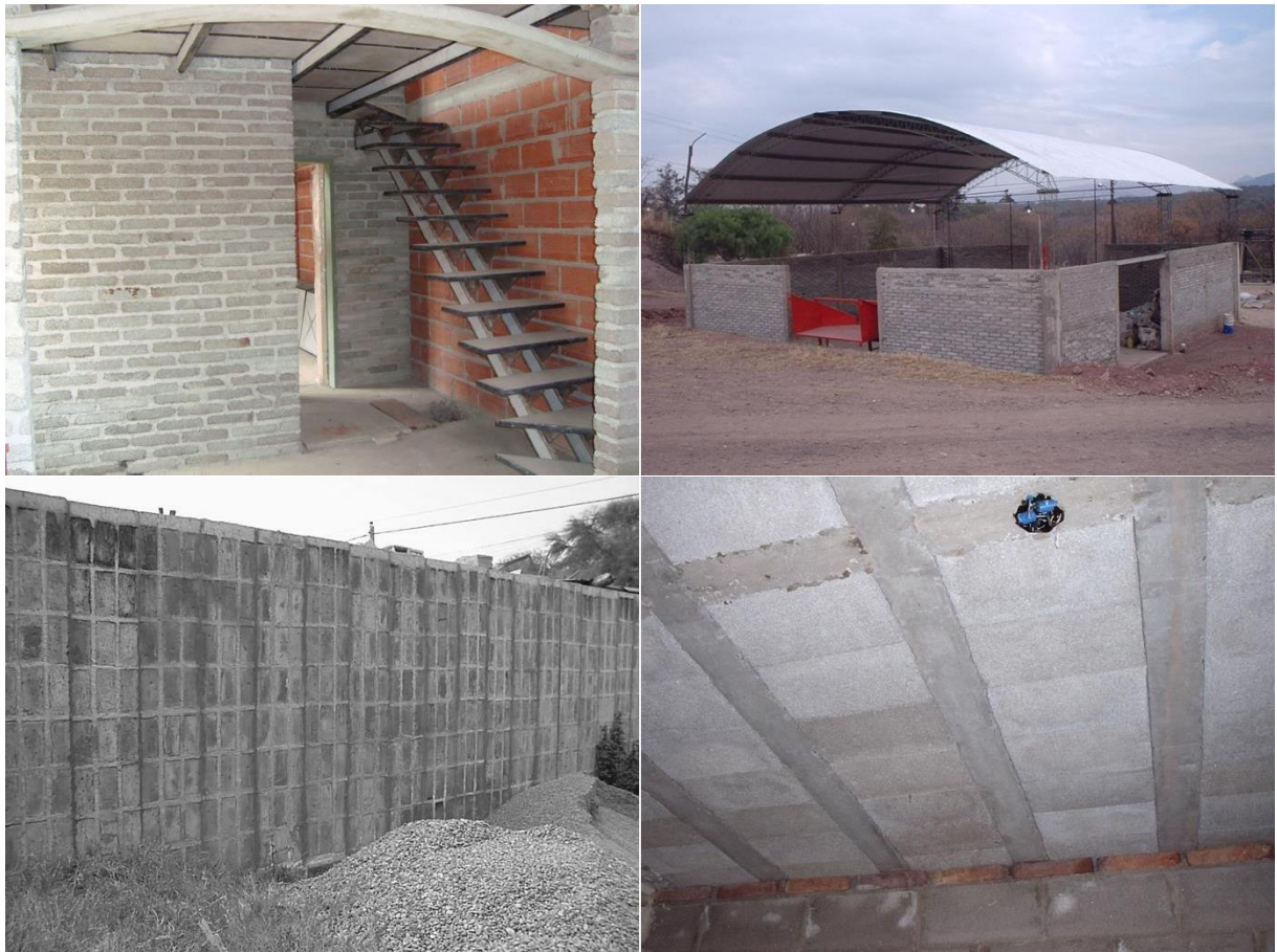
Foto 7. Prototipos construidos con elementos constructivos con PET. Fuente: archivo fotográfico de CEVE.
