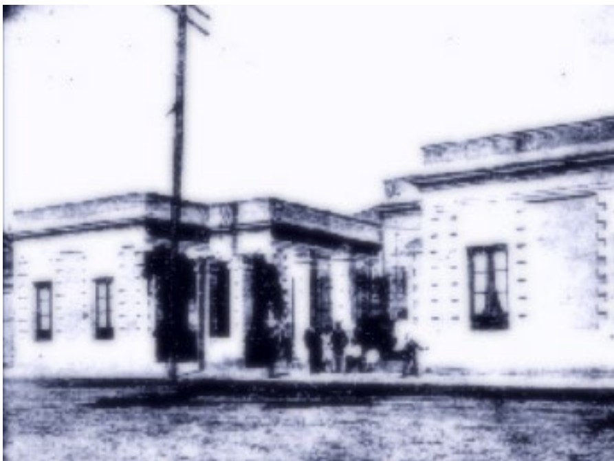
F4 Casas para obreros -Ley 1951- serie II ubicadas frente a la Estación del F.C.C.A. (Garzón Maceda: 1917)
