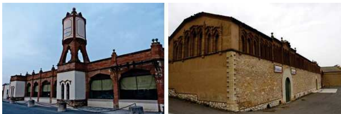
Fig. 37 y 38: Bodega Montblanc. Fuente: https://www.google.com.ar/search?q=celler+modernista+pira&espv=2&biw=1024&bih=476&ctbm=isch&tbo=u&source=univ&sa=X&ved=0ahUKEwjp2-&dpr=1.88#tbn=isch&q=celler+modernista+montblanc
