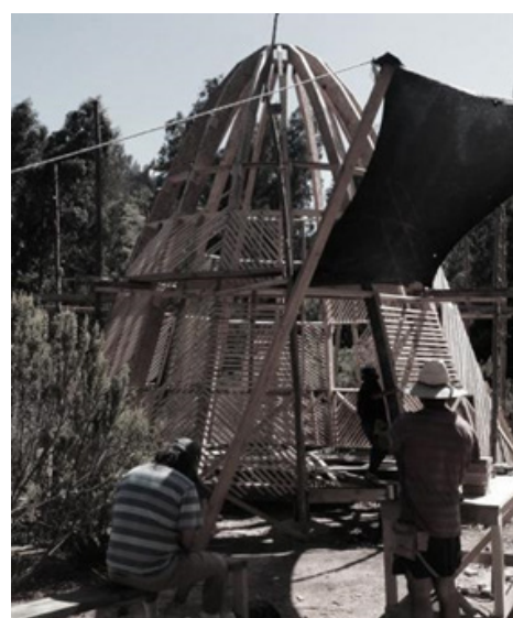
Fig. 18: Proceso constructivo visto desde el Sur-Poniente. Fuente: Elaboración propia.
