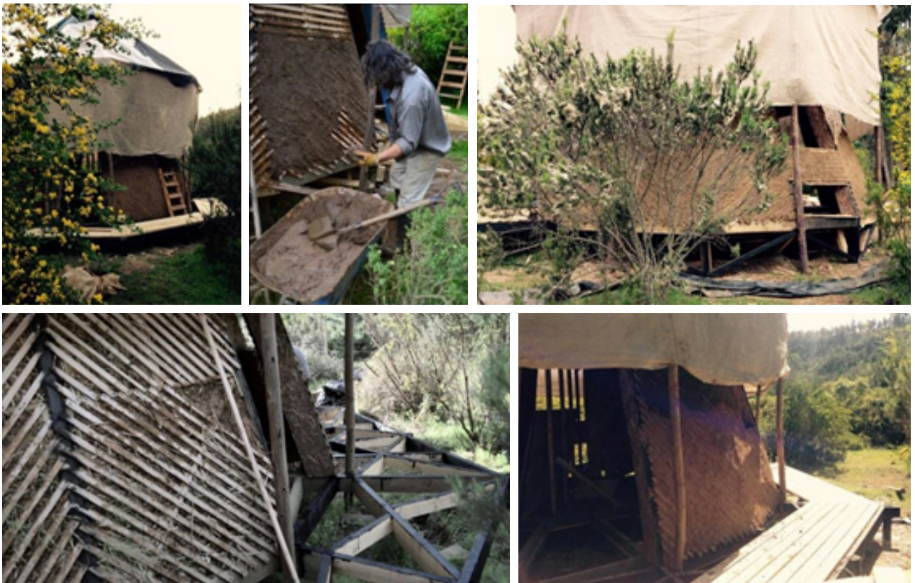
Fig. 28 - 32: Detalles proceso constructivo, con uso de barro. Fuente. Elaboración propia.
