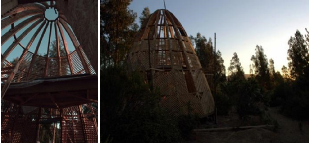
Fig. 26 y 27: Interior en construcción y vista exterior. Fuente: elaboración propia.
