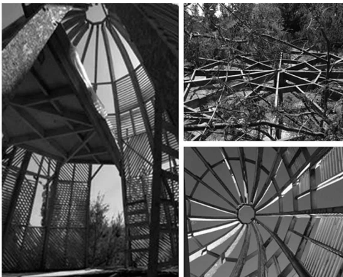
Fig. 23: Fotos del desarrollo constructivo de entramados y modulación incremental; posibilidad de doble/triple altura.
