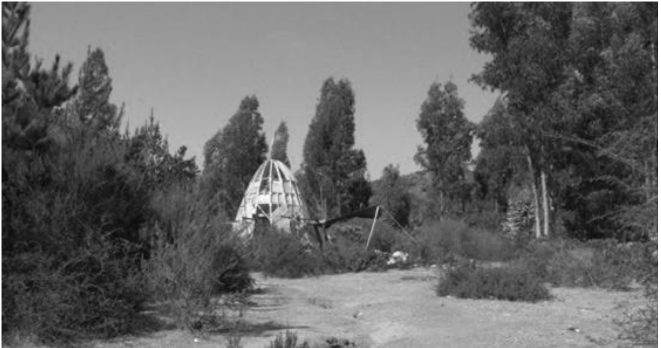
Fig. 33: Interior en construcción y vista exterior. Fuente: elaboración propia.
