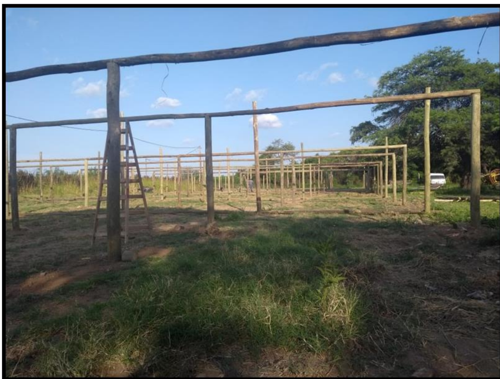
Figura 6. Construcción de los invernaderos.
