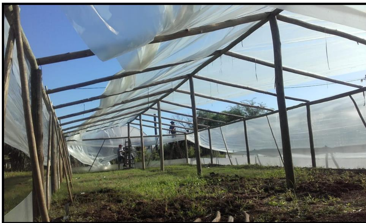
Figura 7. Colocación de plástico en los invernaderos.
