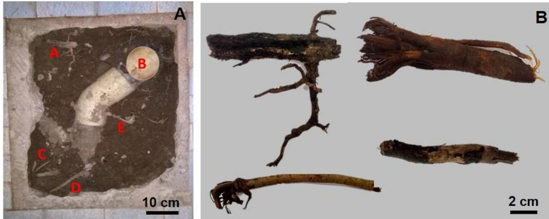
**Figura 6.** Sector de la vivienda dañada y muestras. A: cañería del desagüe sanitario y puntos de extracción de las muestras indicados con A, B, C, D y E (se quitaron el sanitario, los cerámicos y el contrapiso). B: fragmentos de las muestras del interior y de las proximidades de la cañería (A, B, C, D y E).
