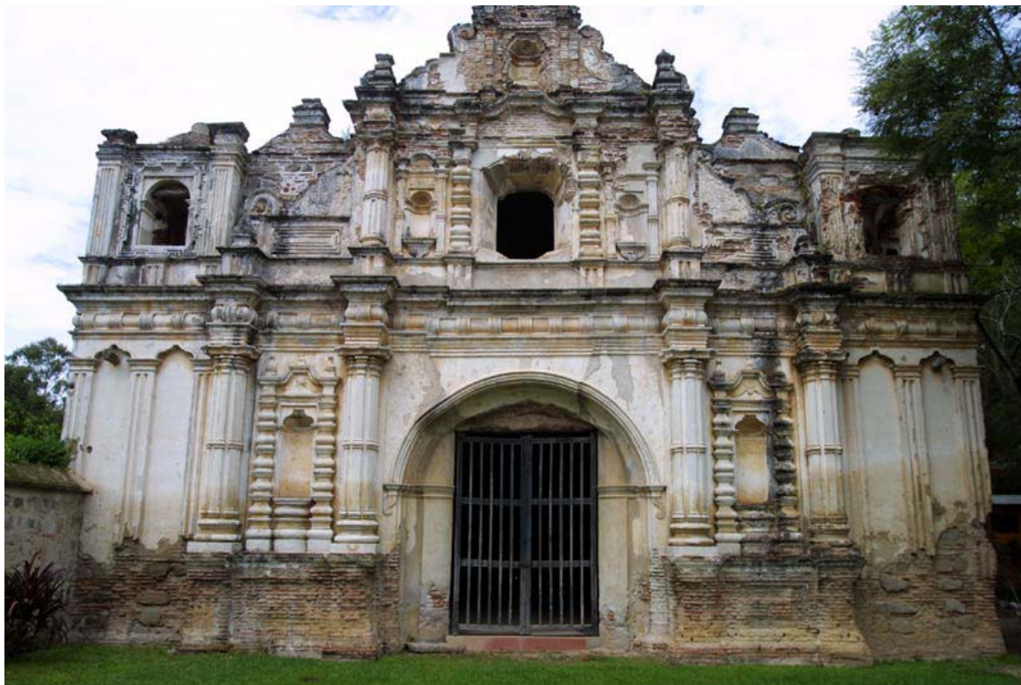
(Fig. 5) La iglesia de San José el Viejo de Santiago de Guatemala, templo donde Vallejo se entusiasmó con el culto a San José. Reconstruido en 1761, fue destruido por el terremoto de Santa Marta de 1773.
