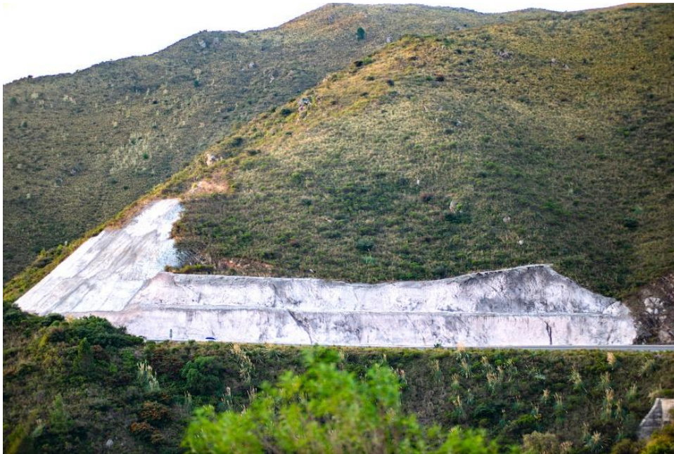
"Remediación" en el Camino del Cuadrado. (Foto Pablo Sigismondi)
