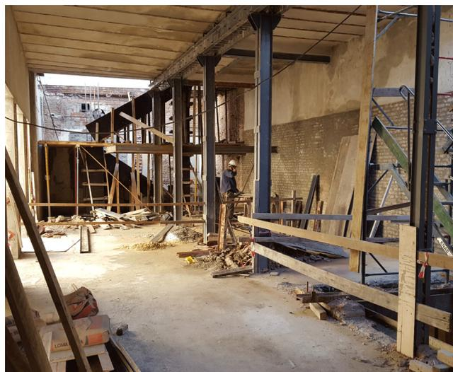
espacios, fue necesario demoler algunos muros para lo cual planteamos una estructura metálica nueva que de alguna manera copiaba la estructura metálica original de los pisos inferiores.
