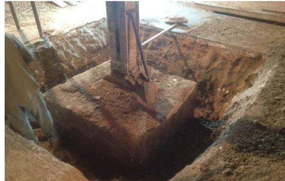
En forma general puedo decir que a las bases existentes se les colocaba una especie de viga perimetral con unos pernos para solidar el hormigón nuevo con el viejo quedando más o menos bases de 2 metros por 2 metros. Pero, como menciono en el audio, las bases existentes tenían diferentes situaciones y nosotros tuvimos que adecuarnos a ello y evaluar un cálculo y forma de intervención específica para cada caso.
