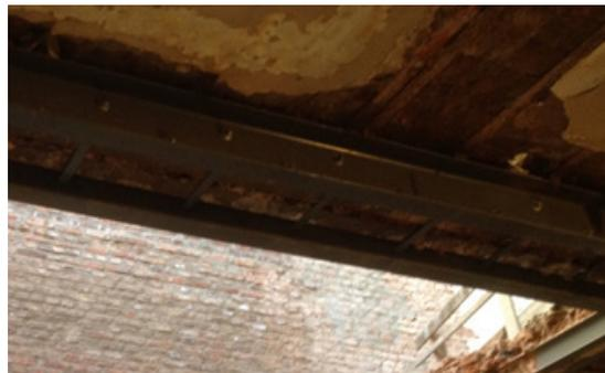
Esto hacía que los dos perfiles trabajaran solidariamente, constituyendo una viga que descarga en las columnas metálicas nuevas y restituya el apoyo de las bóvedas catalanas existentes.
