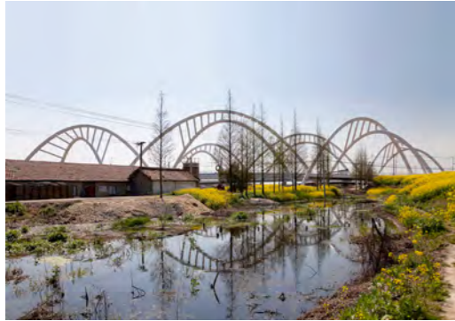
Puentes Gemelos Xidayinggang
