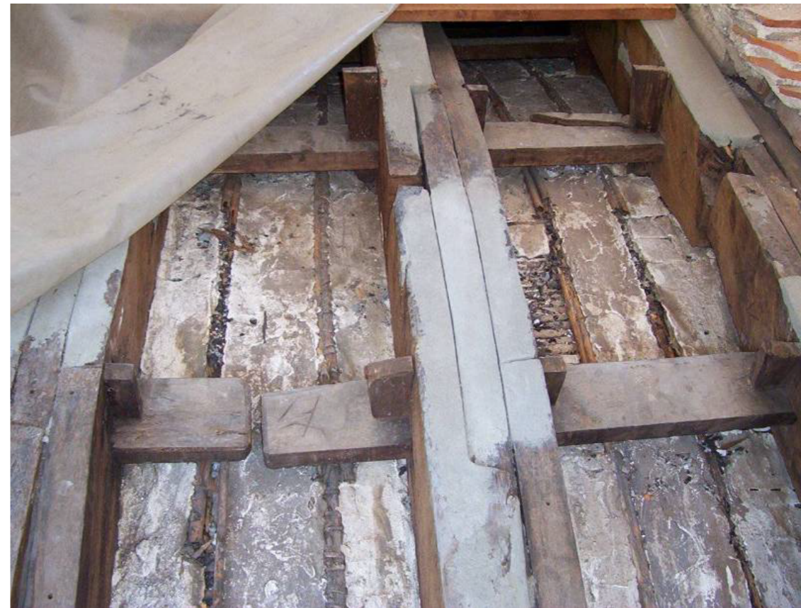
Sector de la estructura recuperado
