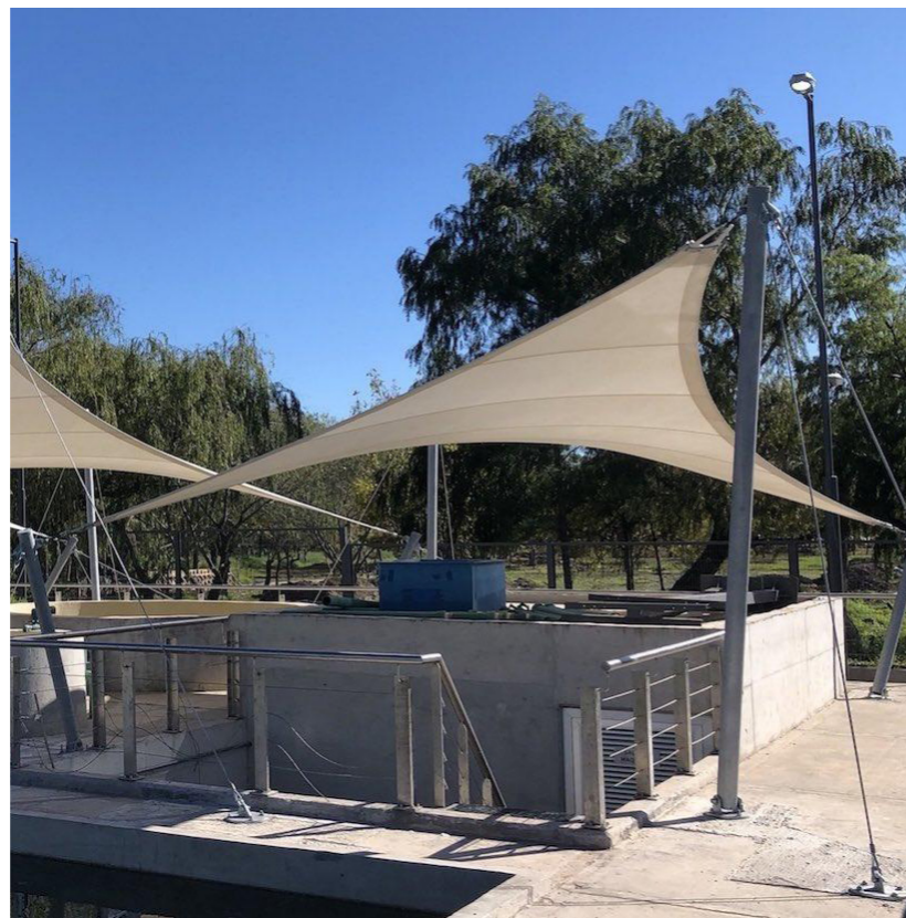
ACUARIO DEL RIO PARANÁ | DINALES SA | WAGG | ARQUITECTURA TEXTIL ANCLAJES EN PUNTOS BAJOS MEDIANTE TENSORES SOLICITADOS A TRACCIÓN
