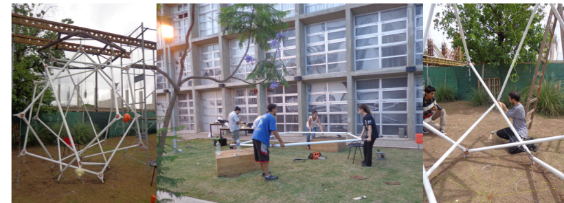
PROCESO DE MONTAJE. ESTRUCTURA AUXILIAR
