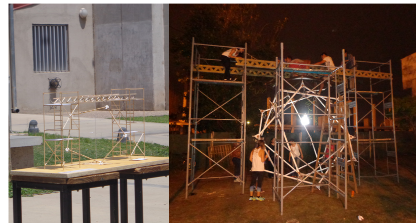
MONTAJE EN OBRA. MAQUETA DE ESTUDIO Y ANDAMIO AUXILIAR CONSTRUIDO
