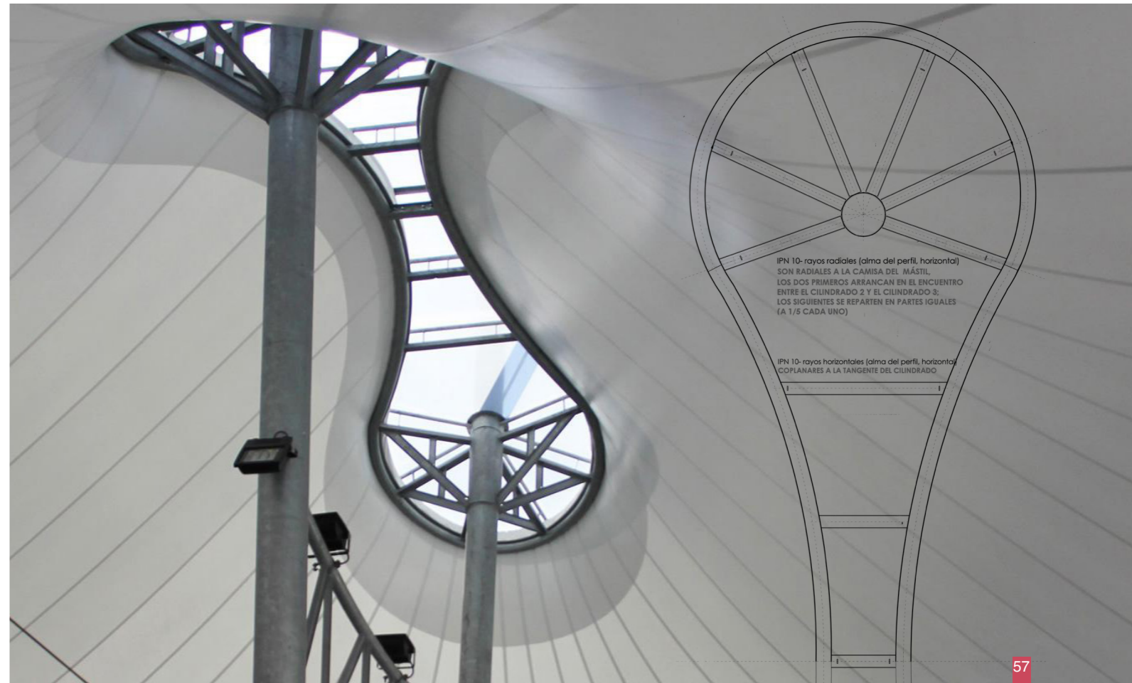
DETALLE MÁSTILES CENTRALES Y LINTERNAS
