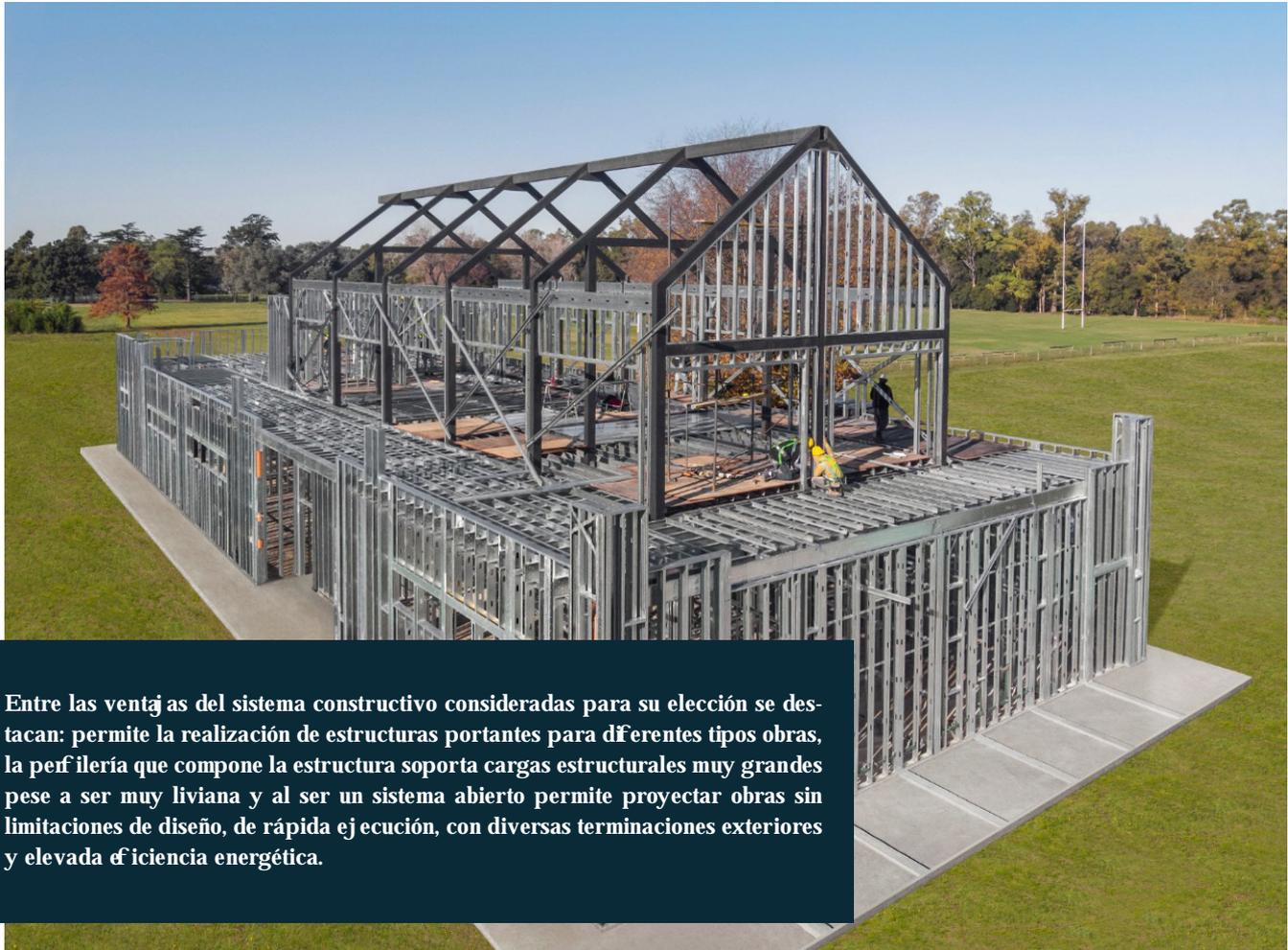
Entre las ventajas del sistema constructivo consideradas para su elección se destacan: permite la realización de estructuras portantes para diferentes tipos obras, la perfiles que compone la estructura soporta cargas estructurales muy grandes pese a ser muy liviana y al ser un sistema abierto permite proyectar obras sin limitaciones de diseño, de rápida ejecución, con diversas terminaciones exteriores y elevada eficiencia energética.
