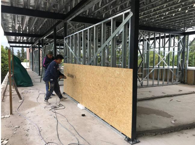
La estructura de la cubierta se resuelve con vigas reticuladas realizadas con acero liviano, que apoyan sobre los pórticos de acero formados por perfiles laminados en caliente. Las mismas se disponen separadas entre 40 cm y 50 cm entre sí y contienen el paquete de aislantes requeridos para el confort de los ambientes.
