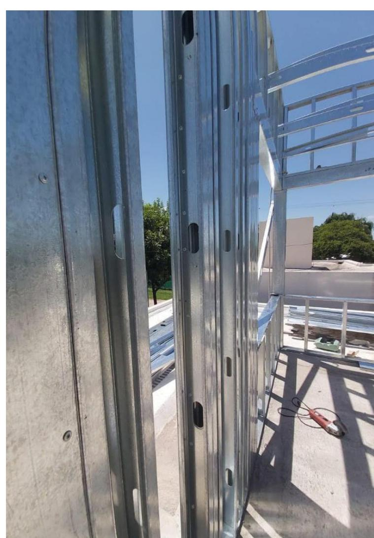
Luego del montaje de los planos perimetrales se procede a la construcción de la cubierta, liviana, compuesta por vigas reticuladas de acero. Es importante destacar que para garantizar la estabilidad del conjunto es fundamental la ejecución correcta de los nudos o vínculos y la incorporación de cruces de San Andrés en los planos verticales o paneles. Para la rigidación del plano de cubierta se utilizaron placas de OSB.
