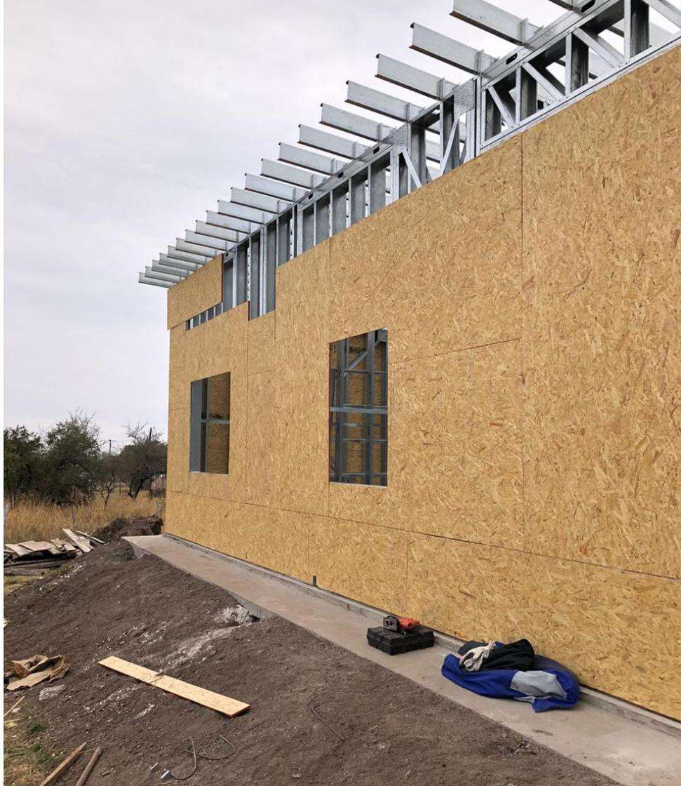
Como ejemplo se presenta el caso de un muro formado por montantes separados 400 mm con una altura de 2600 mm. y sometido a una presión de viento de 0,5 kN/m<sup>2</sup>. Se define una deformación límite igual a la L/600. Se elige la tabla correspondiente a montantes separados 400 mm e ingresando con el valor de presión de viento y la
