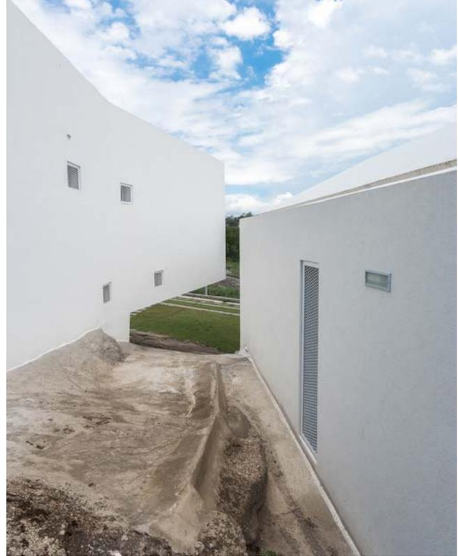
El proyecto presenta la particularidad de ir una parte apoyada en el terreno y una parte volada sobre lo escarpado de la topografía. En estos sectores se dispusieron los encadenados de los muros verticales configurando una viga reticulada en voladizo.
