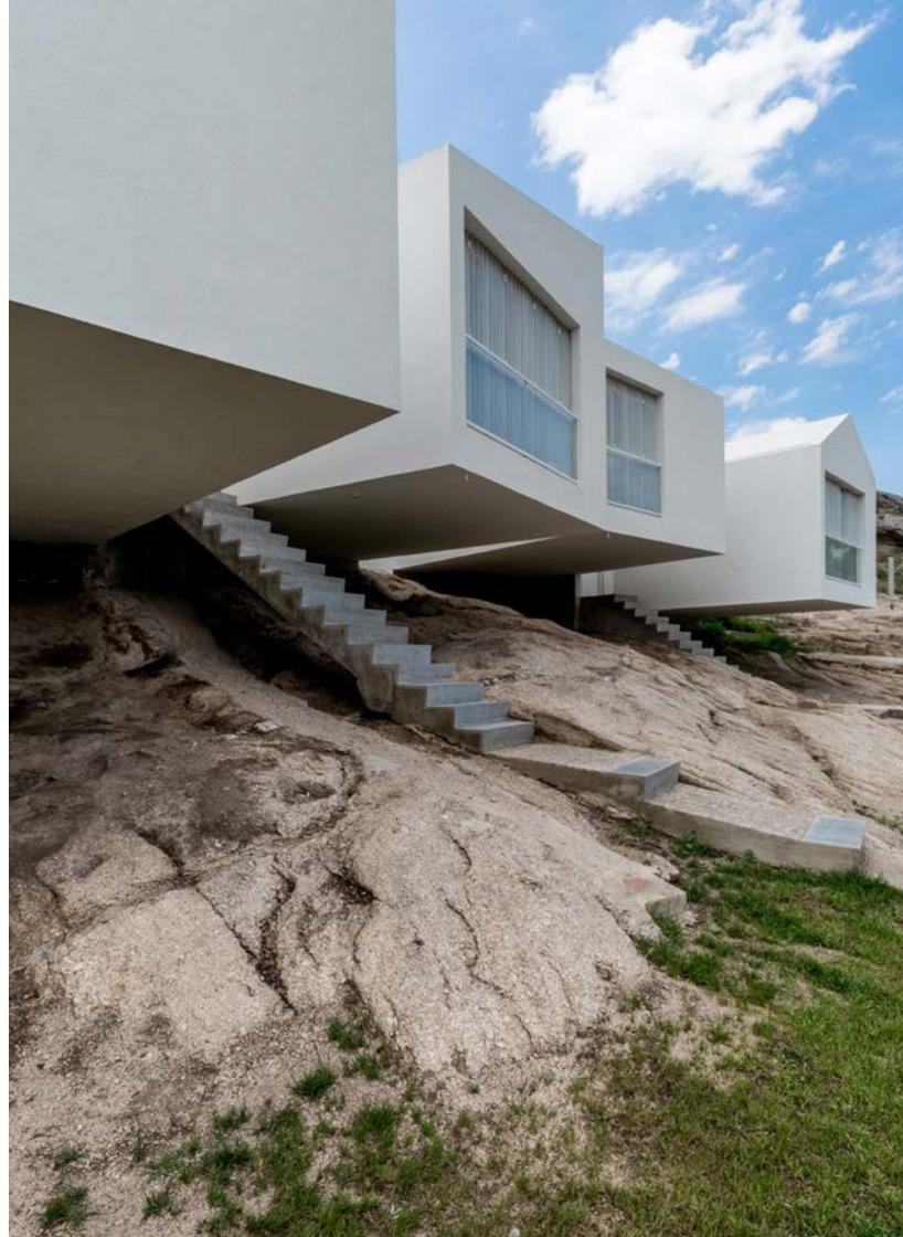
**De la Estructura:** Se buscó el uso de materiales y tecnologías locales posibilitadas por las luces de los espacios diseñados. Losas planas e inclinadas resueltas con viguetas pretensadas y planos resistentes verticales de mampostería de bloques cerámicos huecos portantes encadenada organizan el mecanismo estructural resistente.
