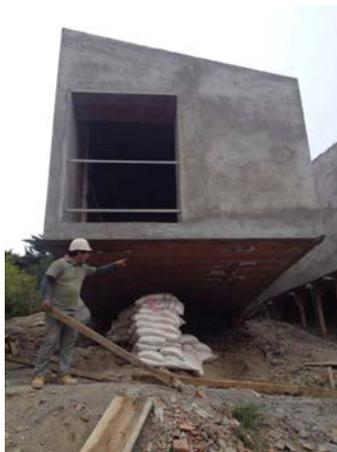
Para este esquema estructural el proceso constructivo juega un rol importante ya que requiere materializar por completo todo el plano vertical para poder retirar los encofrados de las losas de piso y techo. Al trabajar con tensores inclinados se los debió hormigonar primero junto con los encadenados verticales y horizontales para luego rellenar con mampostería los vacíos en forma de triángulos.
