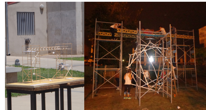
MONTAJE EN OBRA. MAQUETA DE ESTUDIO Y ANDAMIO AUXILIAR CONSTRUIDO
