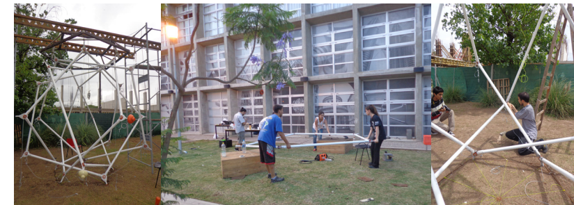
PROCESO DE MONTAJE. ESTRUCTURA AUXILIAR
