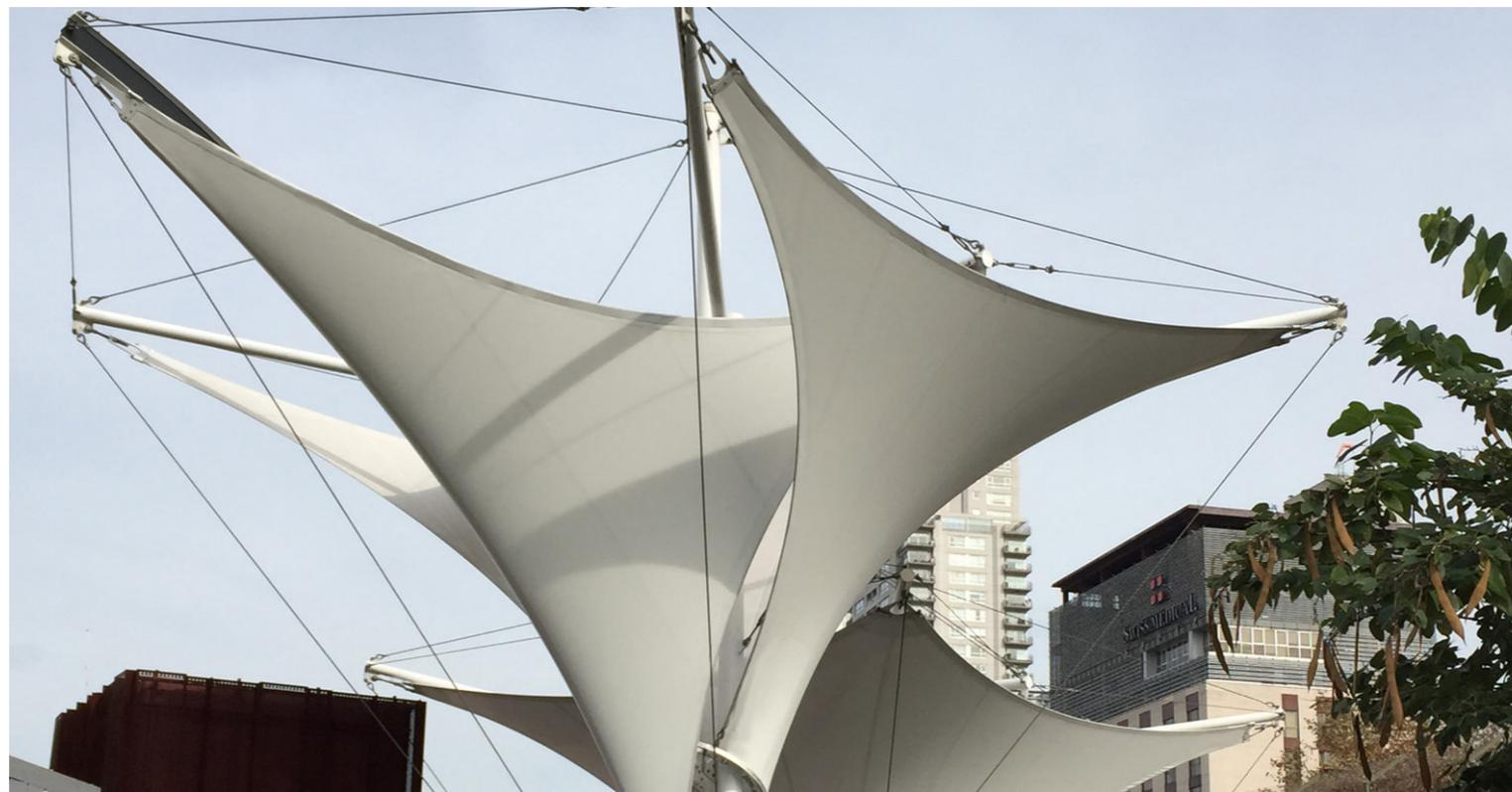
Las primeras, constan de una base textil, la cual le da la resistencia a los esfuerzos estructurales y la flexibilidad necesaria para adaptarse a la forma, con dobles curvaturas, garantizando la resistencia a las cargas gravitacionales y de succión por los vientos. Los cables refuerzan la membrana en sus bordes y materializan el nexo entre la membrana y los herrajes de fijación y anclaje a las bases.
