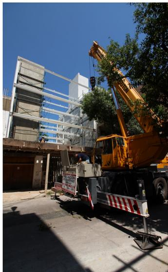
La estabilidad espacial está garantizada por el trabajo conjunto de la construcción preexistente de mampostería portante encadenada, el tubo de hormigón armado y la estructura metálica con triangulaciones.
