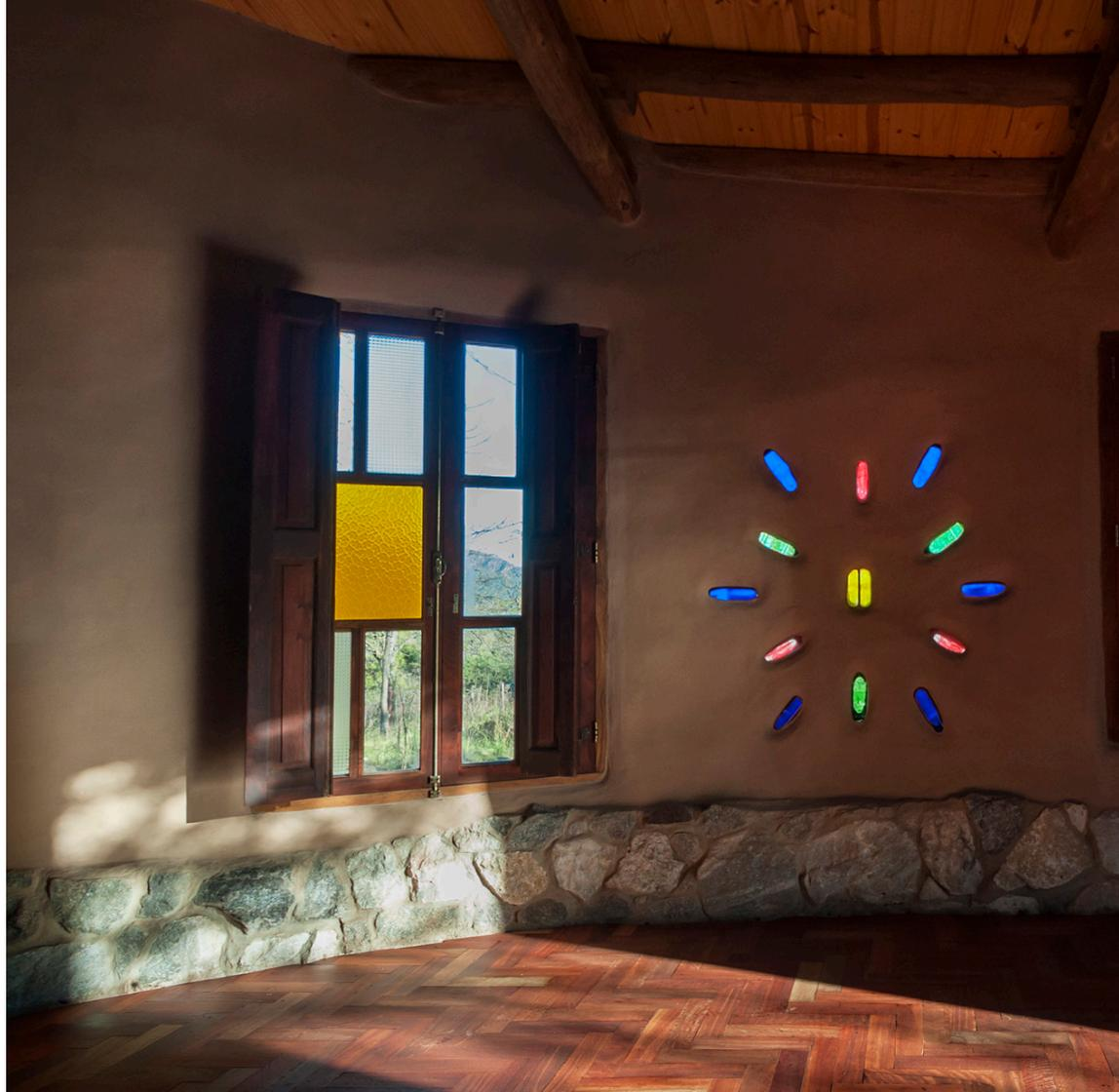
La proporción de arcilla y paja de la quincha se ajustó según requerimientos de aislación o inercia térmica. Para las terminaciones de los muros se realizó un primer revoque de nivelación con arcilla, arena y paja, luego un segundo revoque de arcilla, arena y guano de caballo y por último un revoque fino de arcilla, arena y estabilizantes (cal en el interior y emulsión asfáltica en el exterior).
