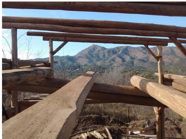
El plano superior que sostiene la cubierta verde, consta de machihembrado de pino que descansa sobre cabios de eucalipto separados cada 50 cm. Estos apoyan sobre vigas principales compuestas por dos rollizos de eucalipto, con un canto plano cada uno, para permitir su superposición y ser unidos mediante varillas roscadas que garantizan el trabajo
