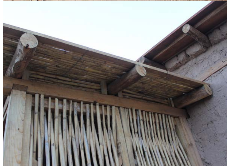
Detalles de construcciones con quincha reforzada
