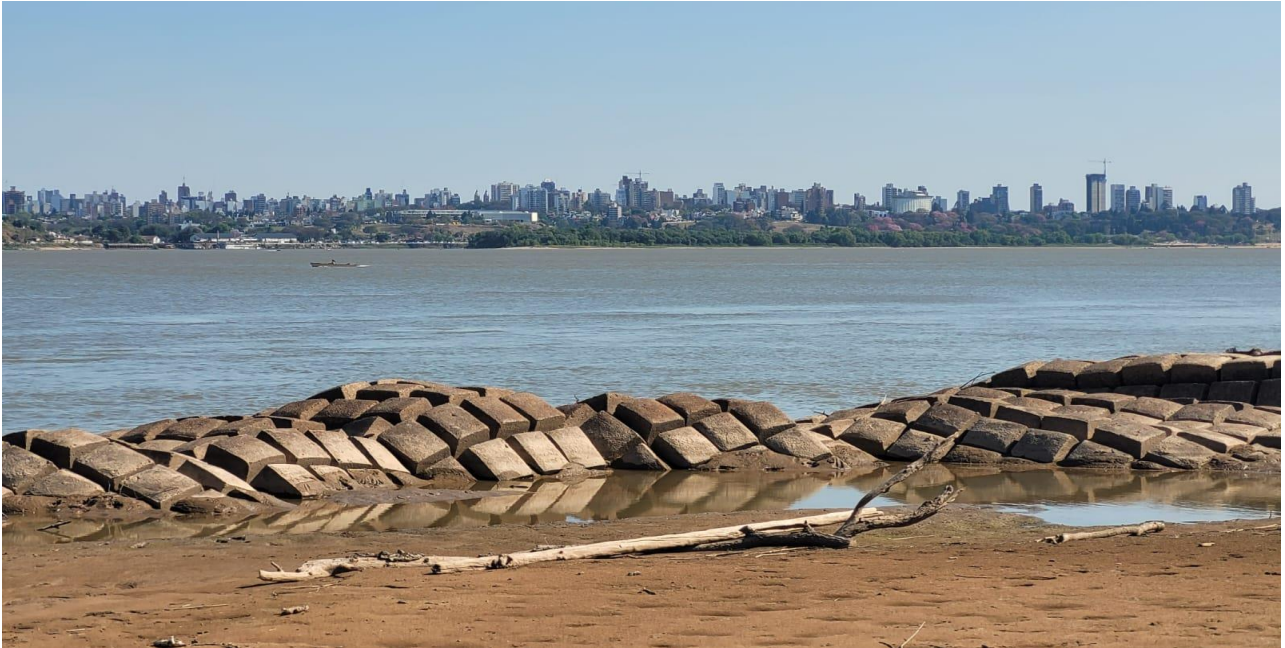
Figura 6: c. Malla del túnel Subfluvial, 2024.
