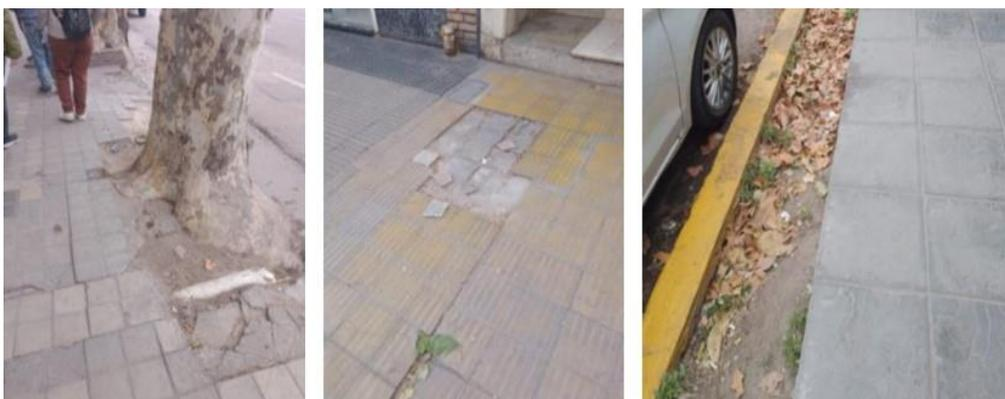
**Figura 11:** Ejemplos de solados de veredas del área de estudio con situaciones problemáticas. De izq. a der.: raíces fuera de la cazuela, deterioro de solados o falta de completamiento a partir de un mejoramiento de la calzada.
