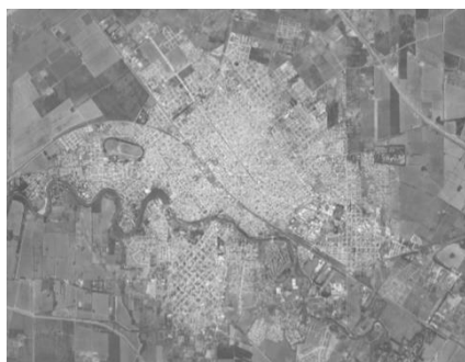
Figura 13: Fotografía aérea de la traza urbana tomada de Google Earth. 1
