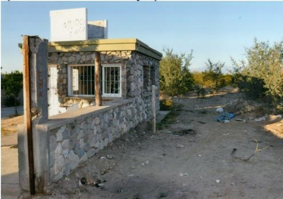
Figura 6. Ingreso al sitio arqueológico, estado de destrucción y vandalismo. Foto: Paula Ruarte
