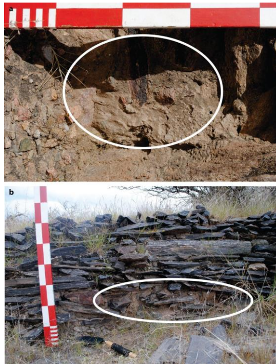
Figura 8. Tipos de mortero: a) mortero de adobe de Morro del Fraile 1 - SIII-R2 (muro 3 vista interior), b) mortero de arcilla y grava de El Carmen 1 - SVI-R33 (muro 4 vista exterior).
