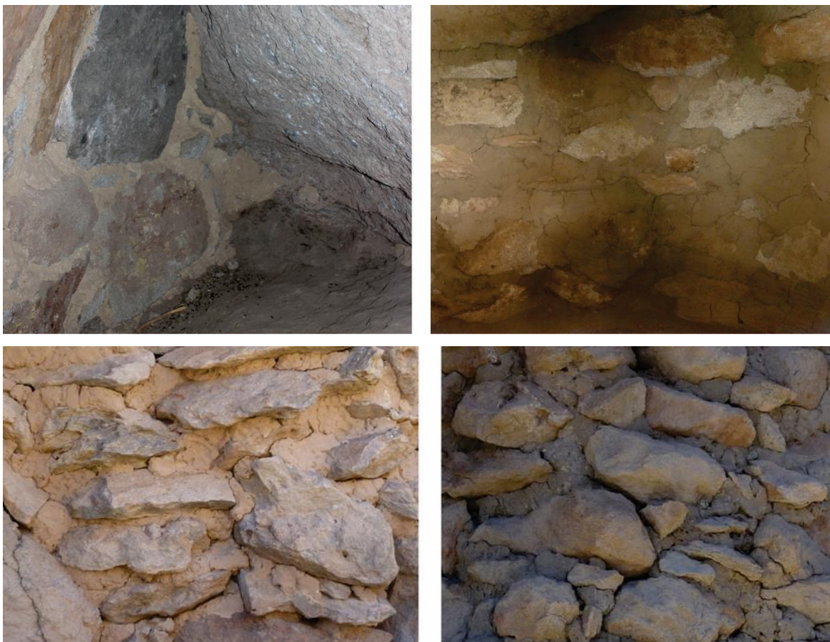
Figura 8. Arriba: Juntas al ras con mortero alisado , en caras interiores. Abajo: Juntas tomadas con mortero aplicado , en caras exteriores.
