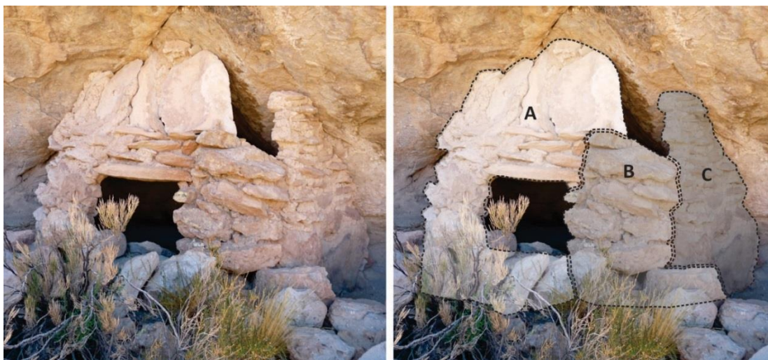
Figura 9. Diferentes tipos de aparejos en una misma estructura que corresponden a sucesivas intervenciones en el tiempo.
