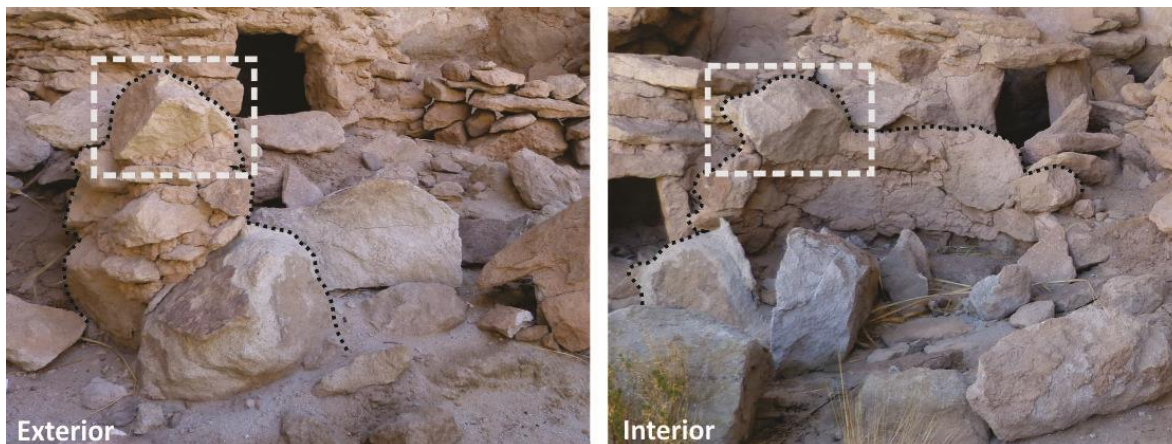
Figura 7. Exterior e interior de una estructura chullparia. Nótase el gesto de rotar el mampuesto de piedra para ubicar su cara plana al interior.
