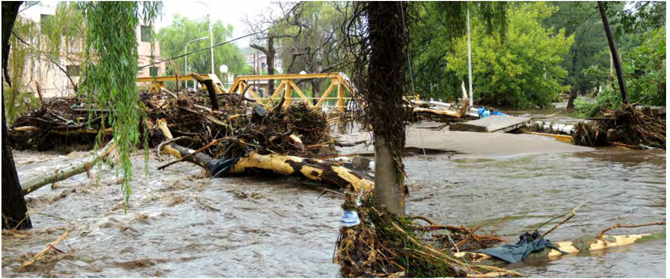
Figura 2. La imagen muestra cómo un puente mal ubicado se convirtió en un obstáculo que retuvo los materiales arrastrados por la crecida, represando el agua que se desbordó por los laterales (e incluso le pasó por encima) inundando un amplio sector del centro de la localidad de Río Ceballos.
